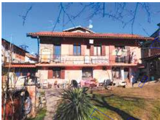
facciata principale prospiciente la corte
