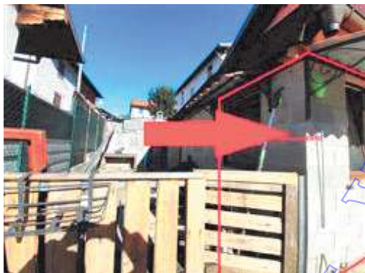
Ampliamento deposito - vista laterale
