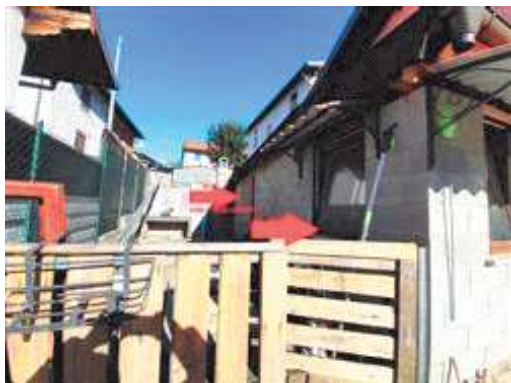
fori serramenti - vista esterna
