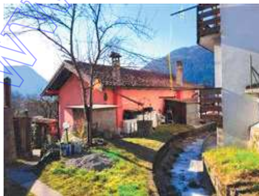
facciata posteriore affacciata sul rio Aip
