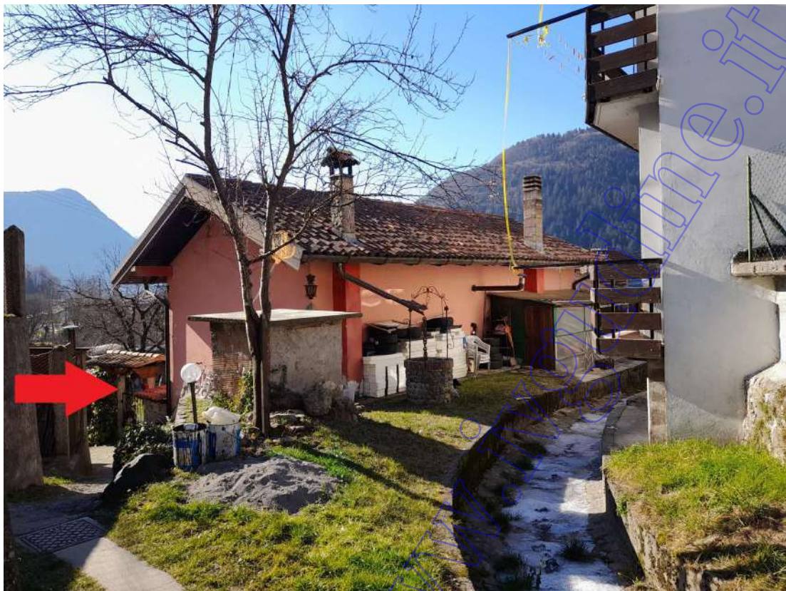
Facciata posteriore con baracca/serra da demolire e accesso alla proprietà
