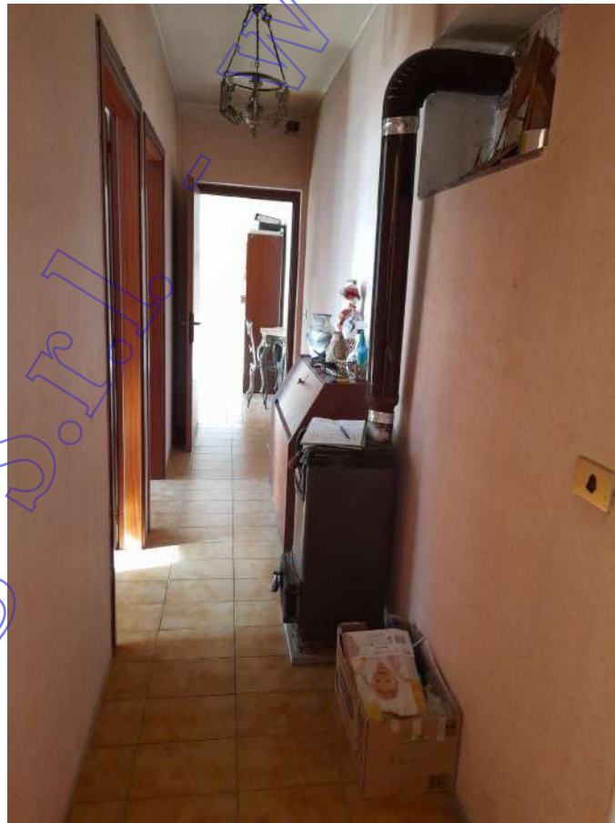
Corridoio al primo piano e stufa con canna fumaria non a norma
