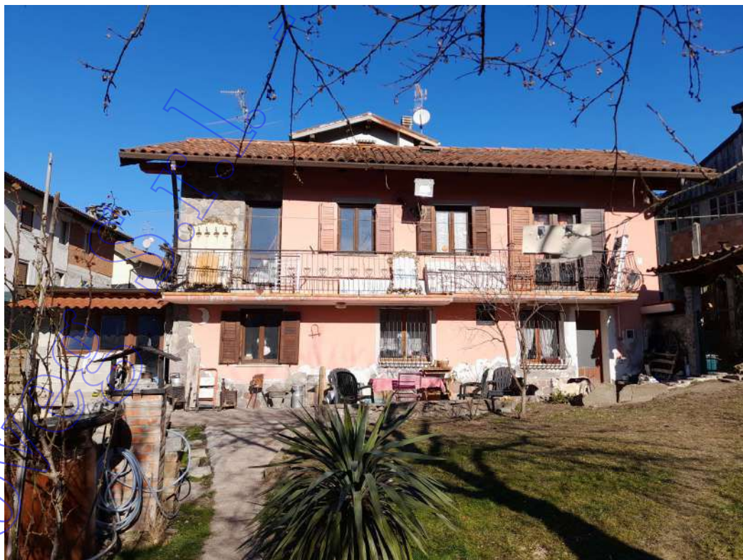
Facciata principale prospettante p.c. 523 – corte – non in proprietà
