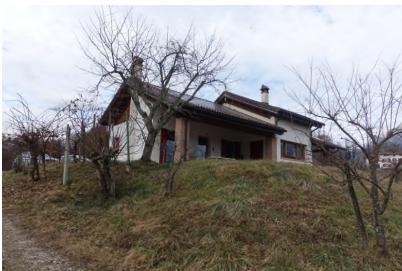
Vista fabbricato principale
