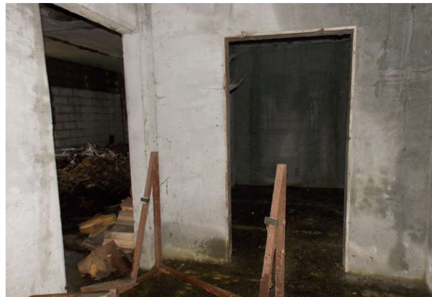
43B - ingresso pedonale capannone
