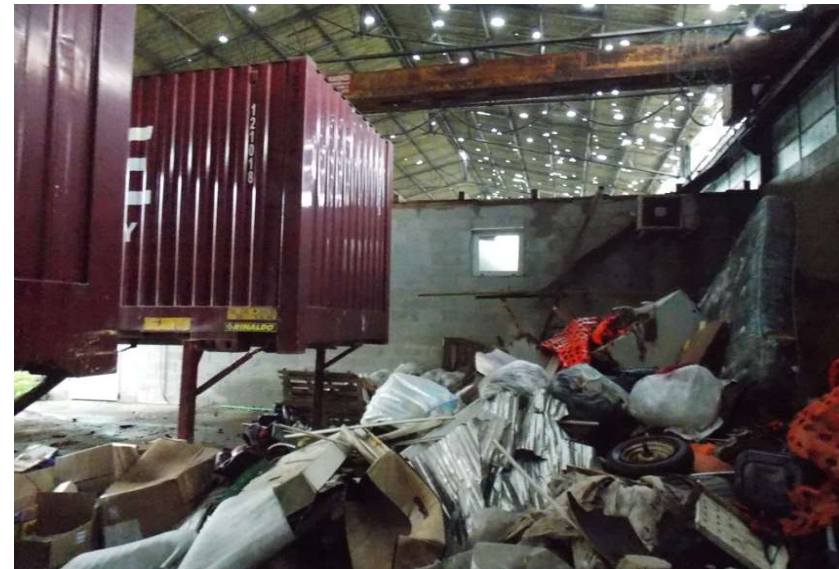
19B - porzione di capannone in prossimità del corpo sporgente
