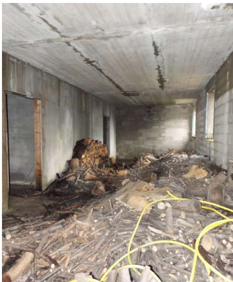
32B - locale capannone a lato ingresso
