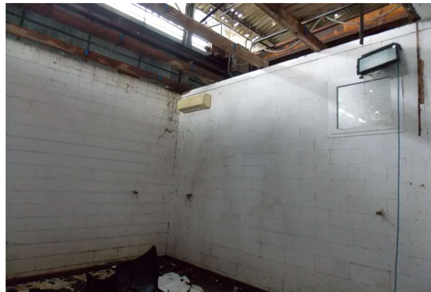
21B - porzione capannone
