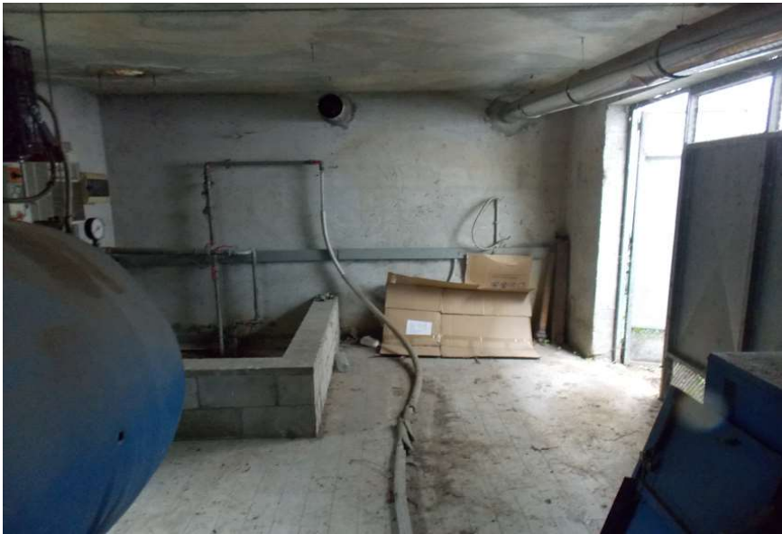
57A - interno centrale termica
