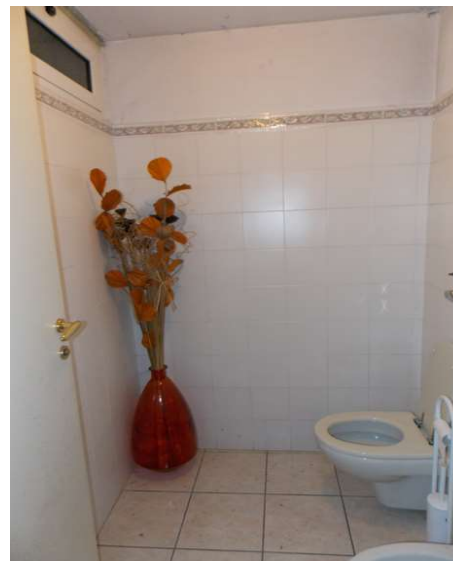
9A - bagno piccolo interrato
