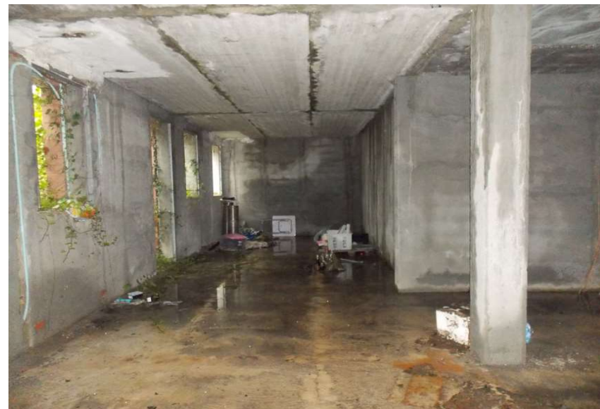
36B - locale a "L" a lato ingresso
