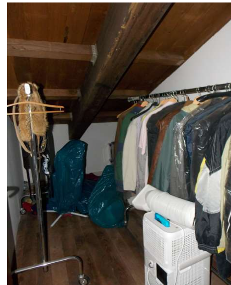
29C - ripostiglio lato scala
