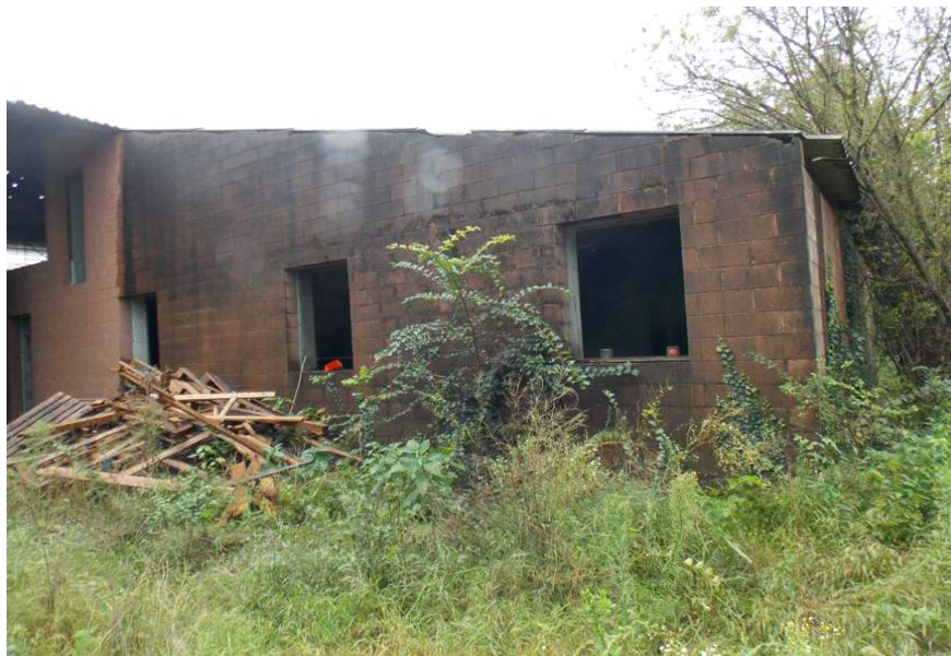
26B - corpo sporgente del capannone su area libera interna
