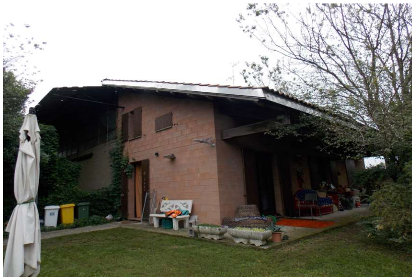
8C - vista villetta a confine con il capannone
