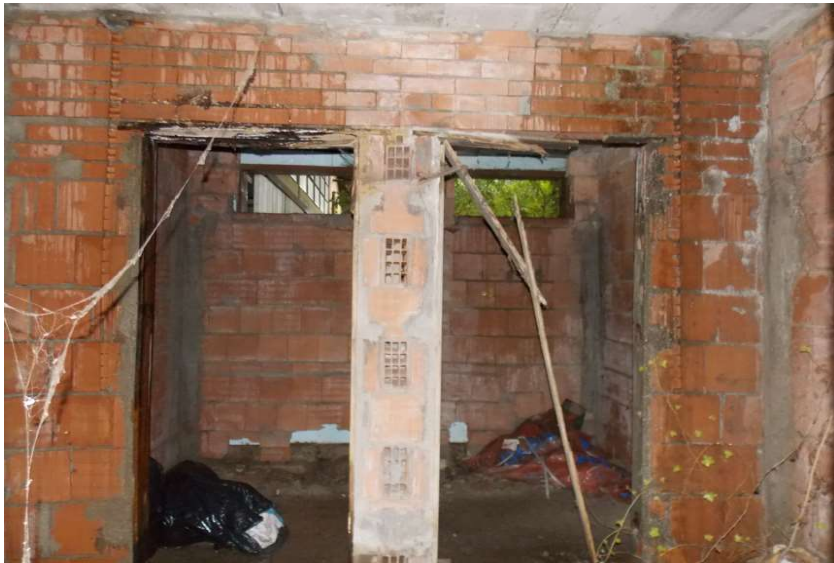
41B - bagni al rustico del capannone
