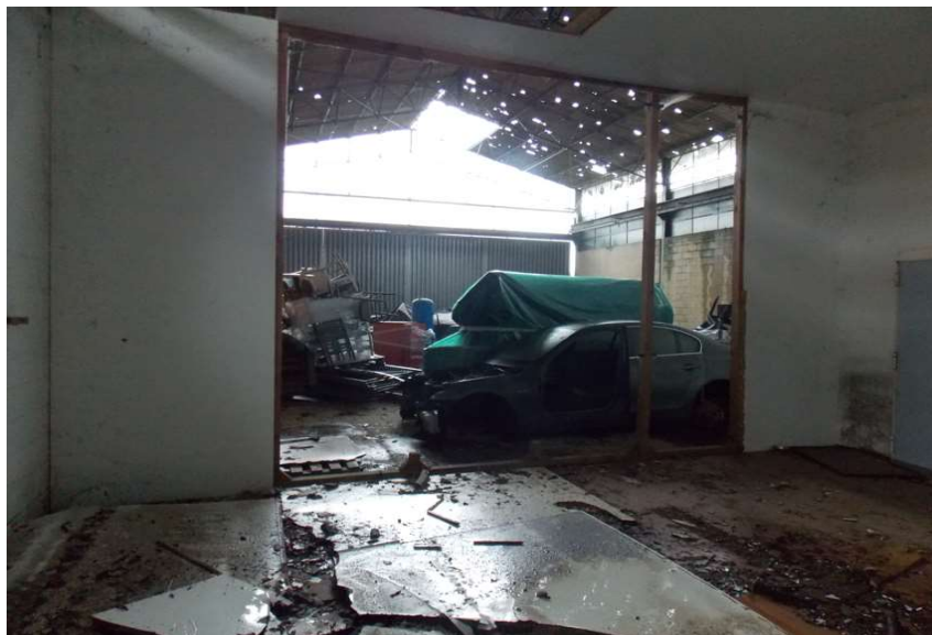
20B - porzione di capannone
