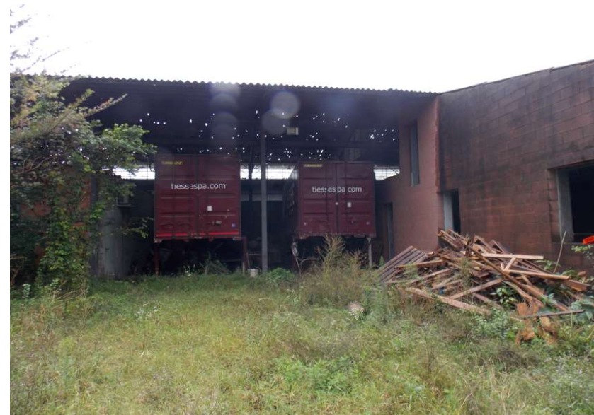
25B - capannone lato verso area interna
