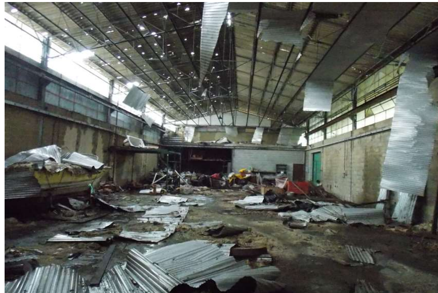
18B - corpo centrale capannone
