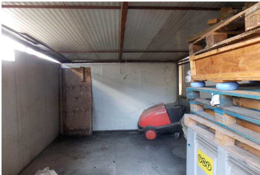
5 - interno ripostiglio da demolire
