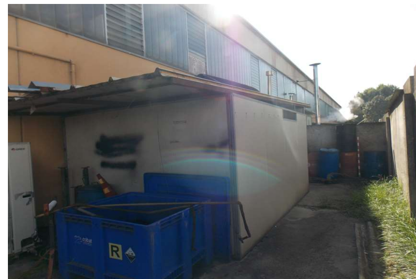
4 - ripostiglio esterno da demolire
