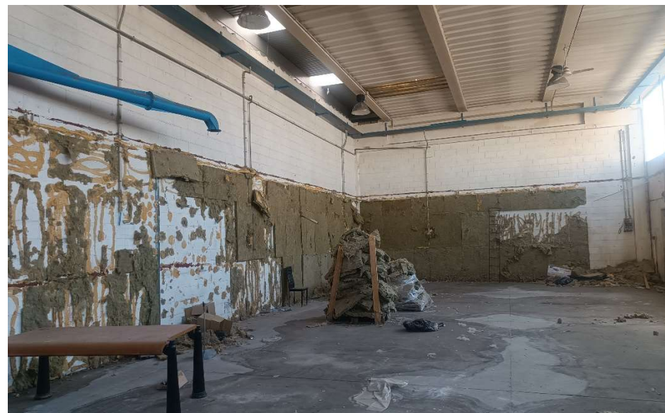
10 - capannone spazio laterale
