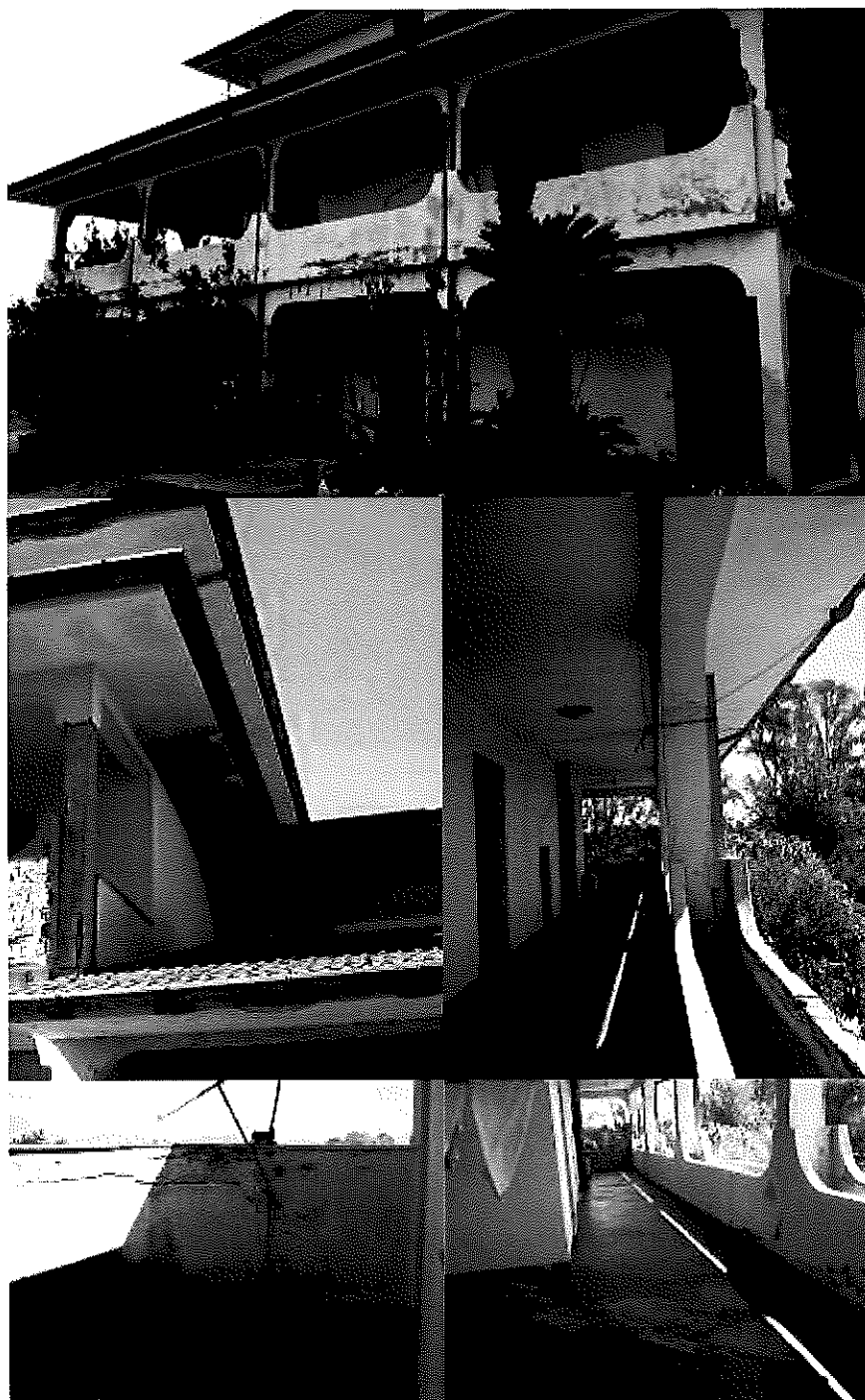
Figura 5: Vista dello stato di degrado degli esterni
