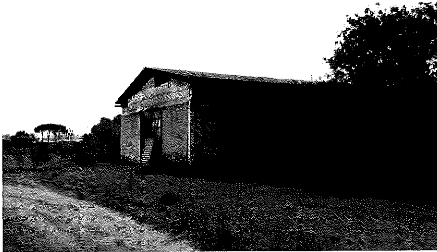
Figura 10: Fabbricato ad uso Magazzino sulla part.113
