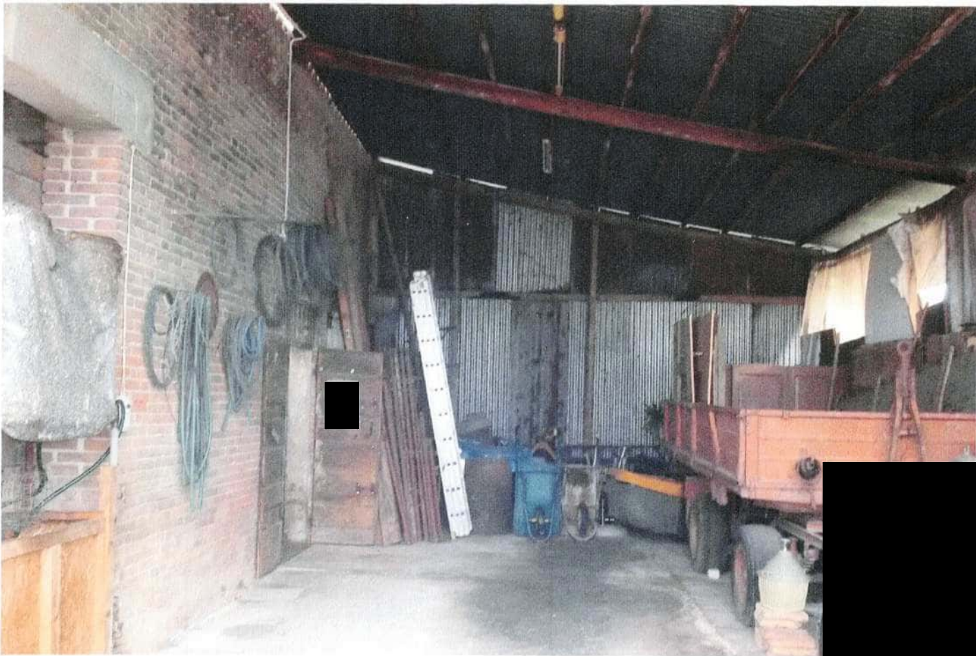
Portico con travi in legno (Lotto1)
