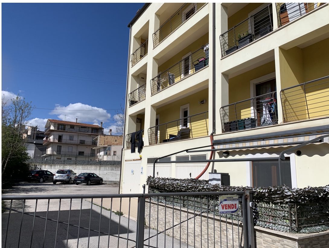
FOTO N.2 Vista esterna lato ovest : al primo piano partendo dall'angolo le due campate della loggia del sub.25 (ufficio)
