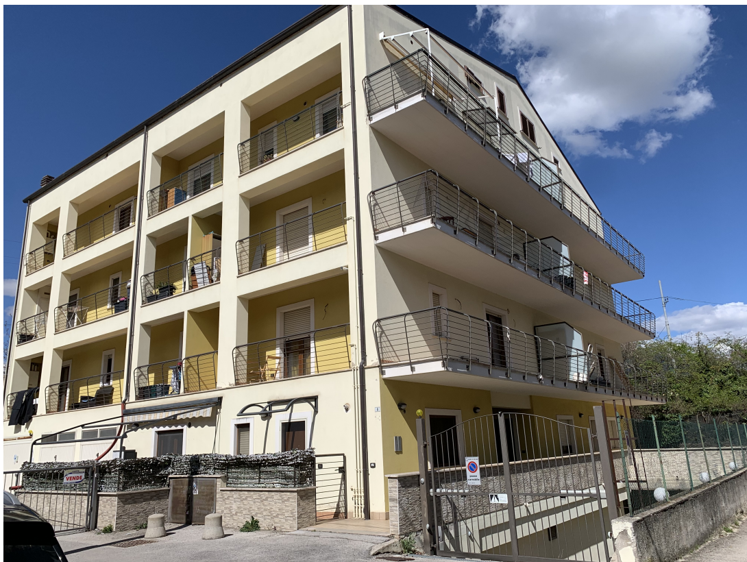
FOTO N.1 Vista esterna dall'angolo sud-ovest del Condominio.
