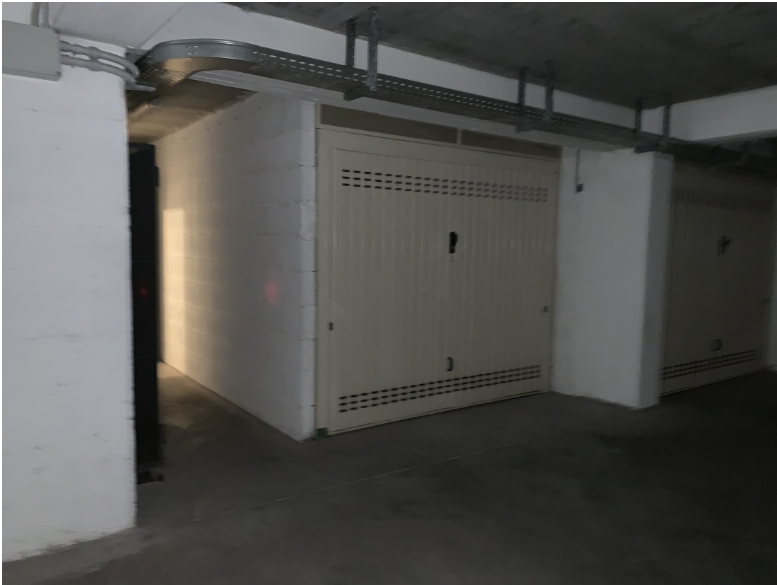
FOTO N.12 Vista esterna garage sub.7
