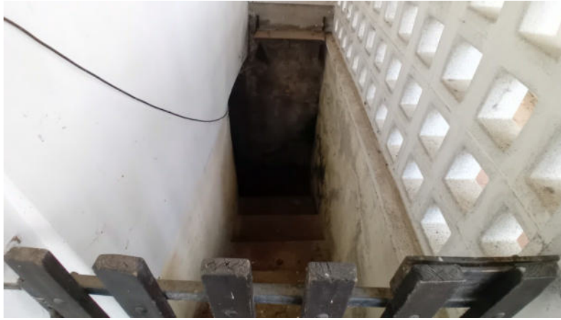
Scala accesso alla cantina
