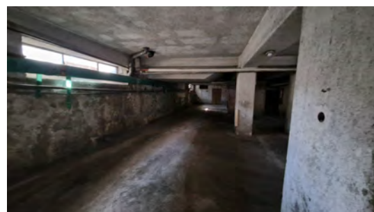
Autorimessa identificata in catasto con Sub 18
