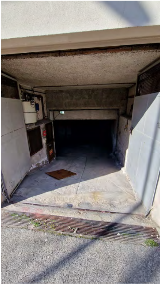
Rampa accesso Autorimessa (Via Australia)
