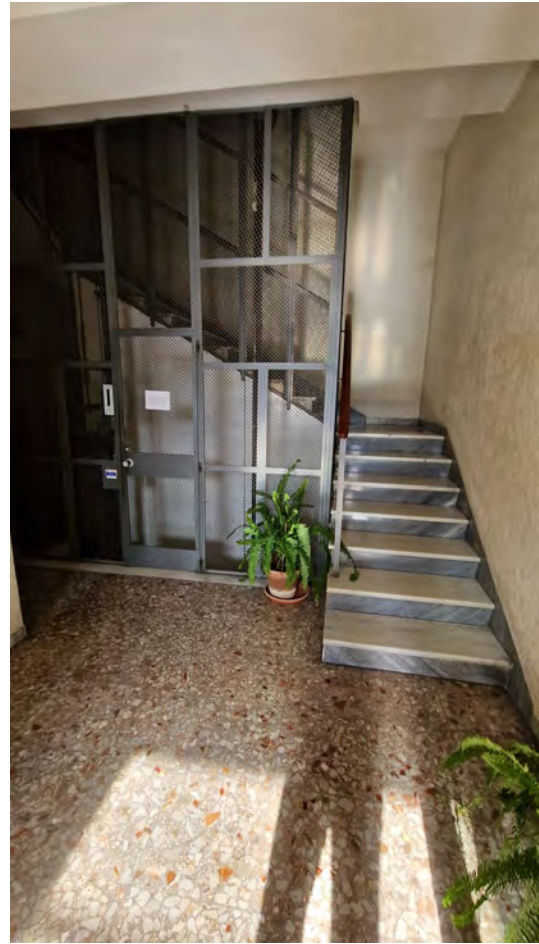
Vano scala Condominiale
