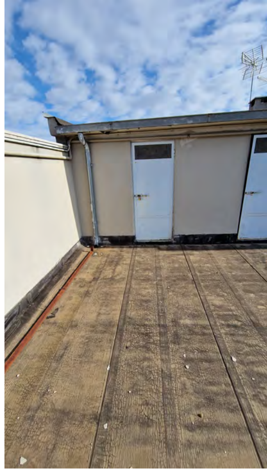
Porta ingresso Locale di sgombero
