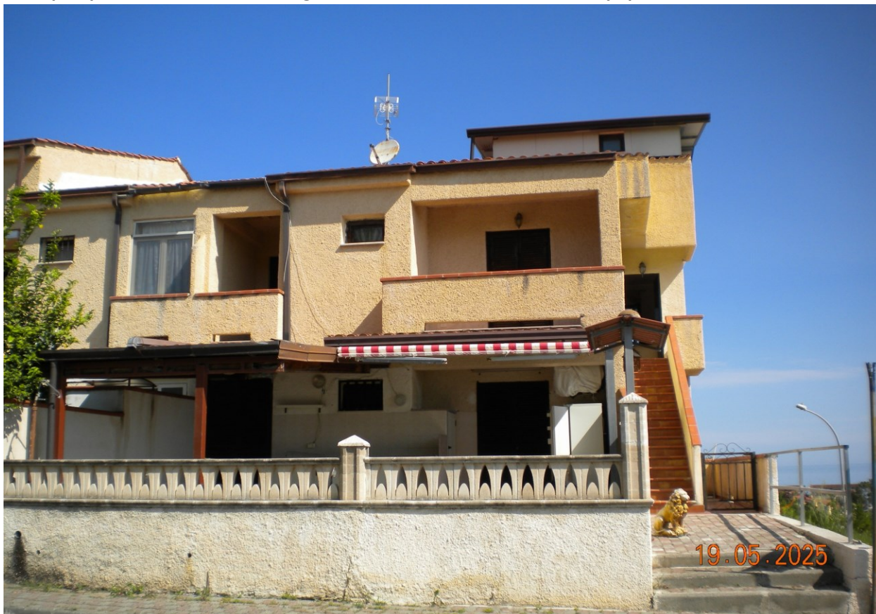
Vista prospettica da Sud-Est lato ingresso esclusivo Strada Via Florida, p. primo e secondo sottotetto
