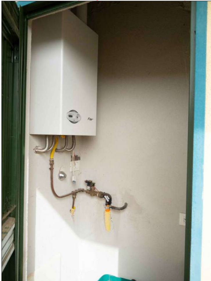
FOTO N. 7 - Ripostiglio esterno - vista interna)
