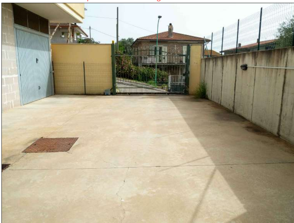
FOTO N. 14 - Rampa Comune dei Garage
