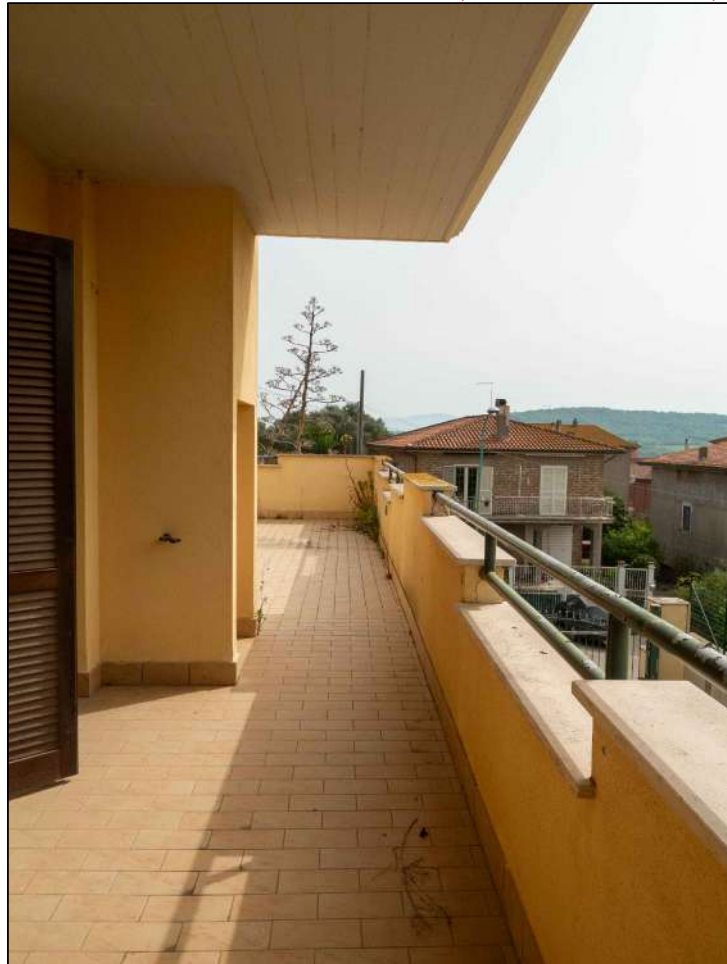
FOTO N. 8 - Terrazza Esterna (vista camino esterno)
