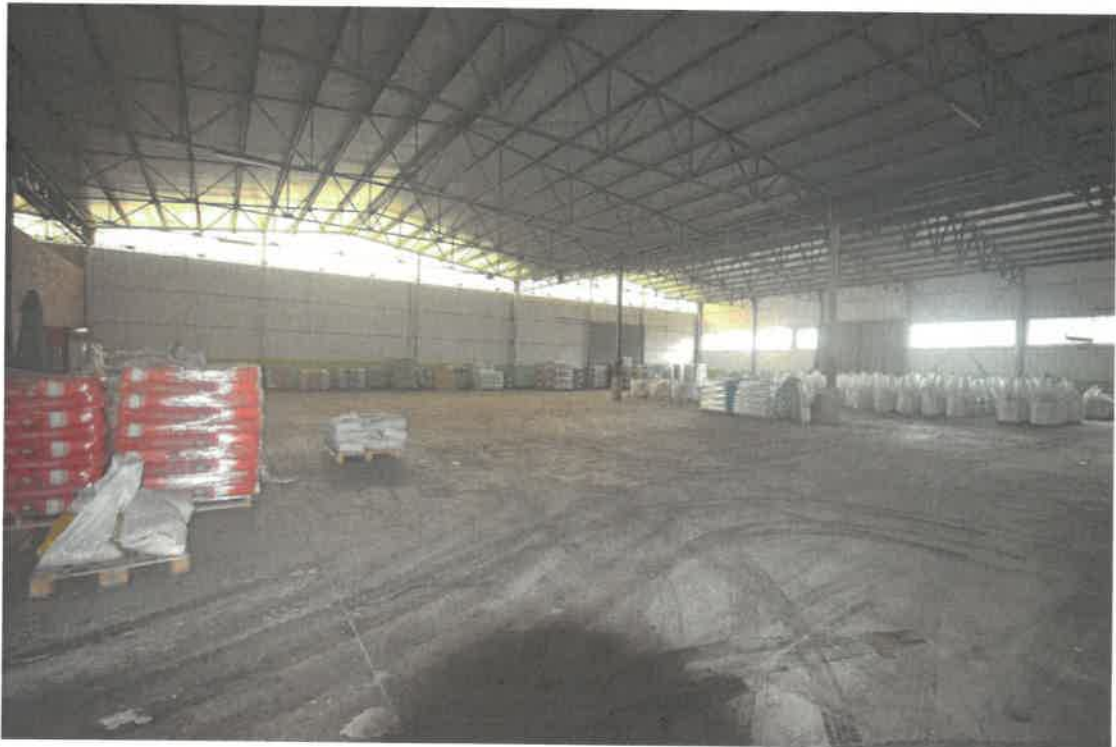
Vista interna del magazzino di dimensioni m.41 x 52
