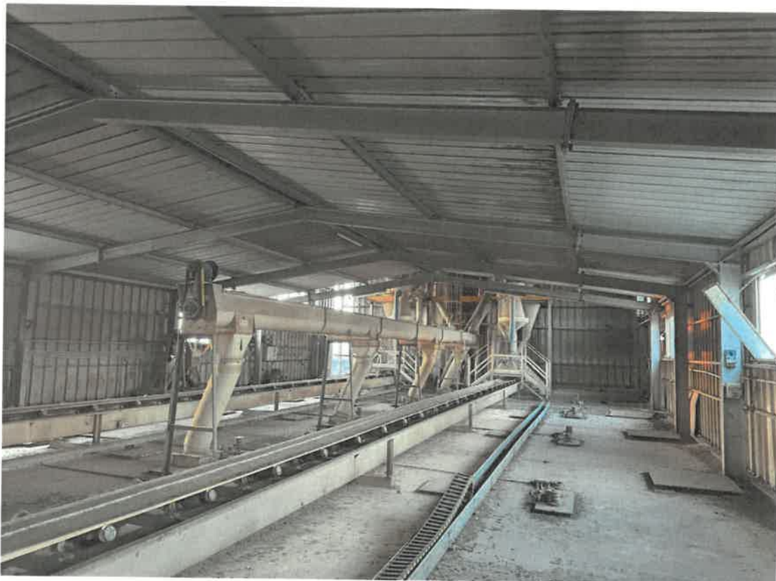
Particolare copertura Centro Selezione Sementi
