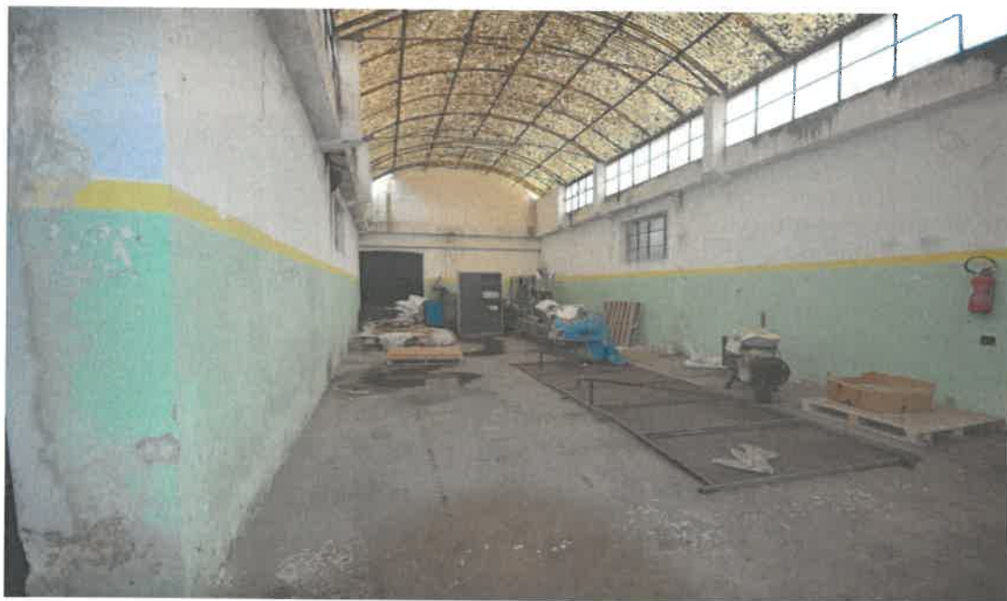
Mangimificio -locale con copertura in lastre di materiale plastico traslucido
