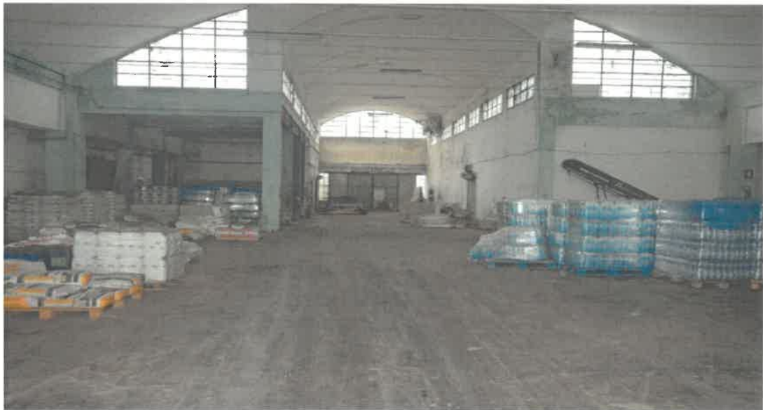
Mangimificio vista interna corpo di fabbrica di dimensioni m. 50 x45 - locale centrale
