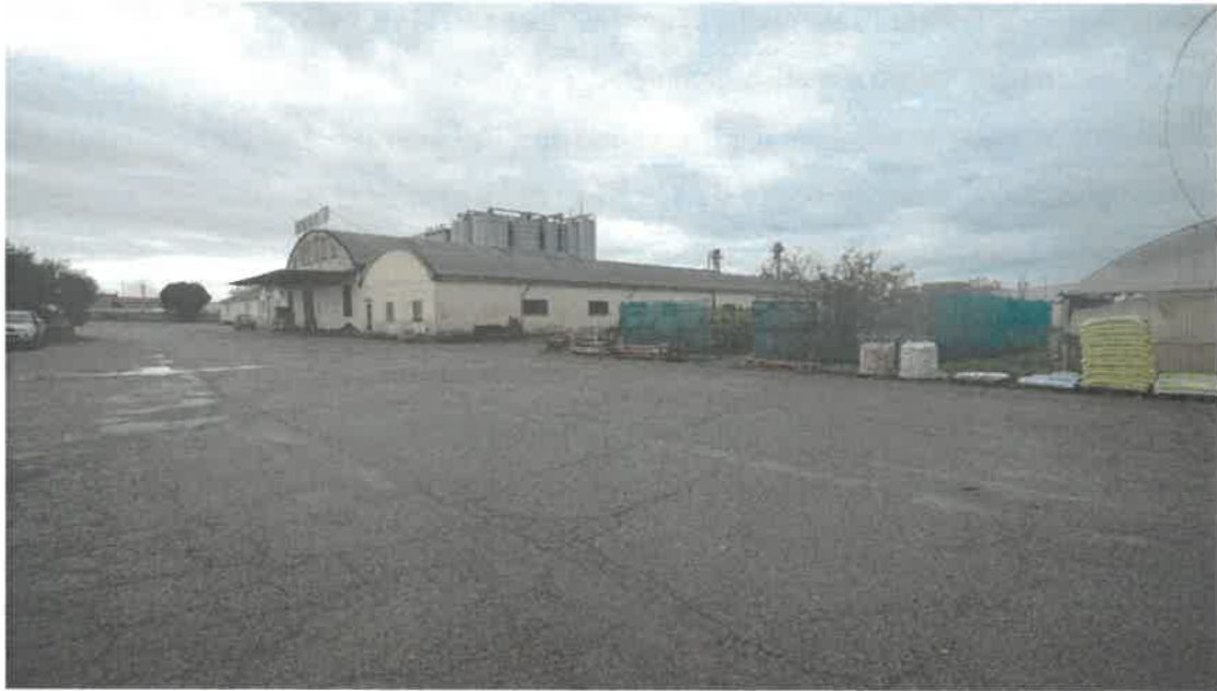
Mangimificio vista esterna sul corpo di fabbrica di dimensioni m. 49,40 x 45,60
