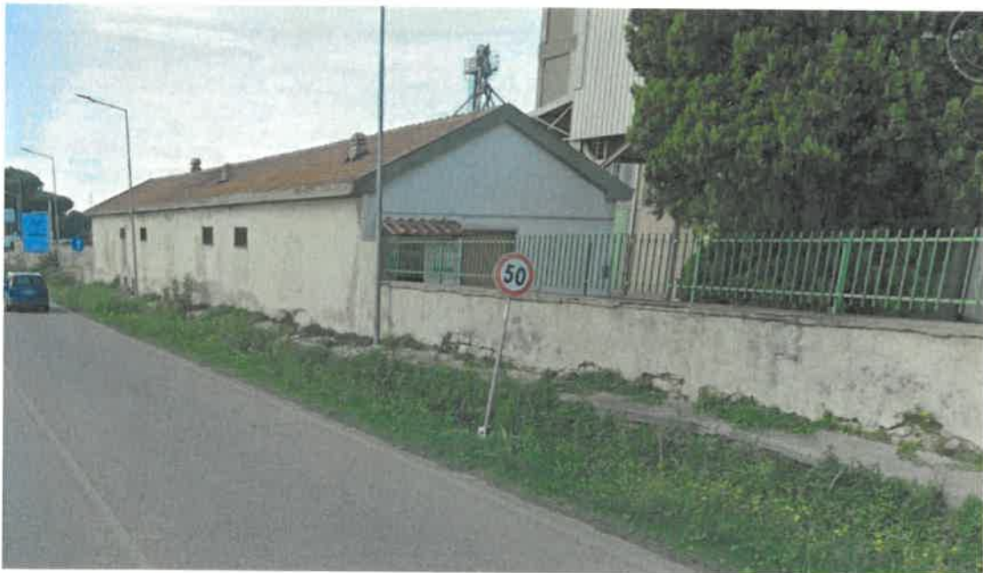
Palazzina Uffici Operativi
