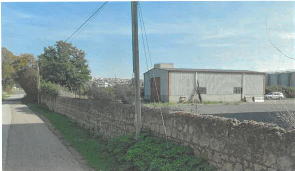
Magazzino deposito – vista da Strada Vicinale Vecchia della Stazione
