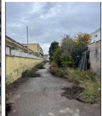
Vista del lotto su cui insiste il compendio pignorato dal Cancellato B
