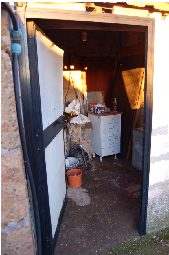
Foto 39 - Porta d'ingresso al magazzino
