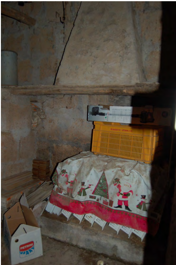
Foto 42 -Vista interna del magazzino –ambiente 2
