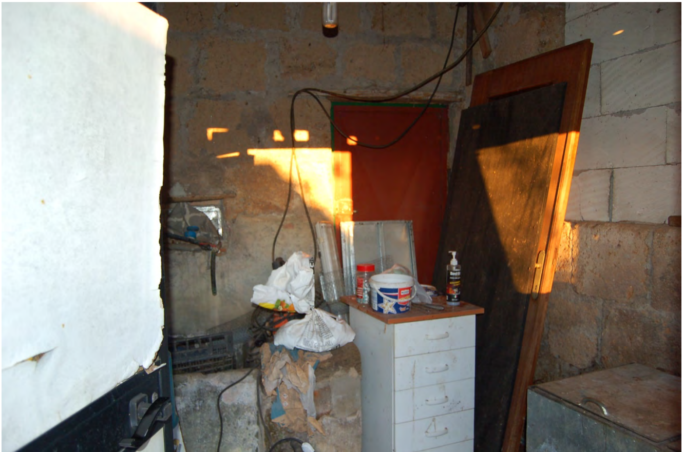
Foto 40 - Vista interna del magazzino –ambiente 1
