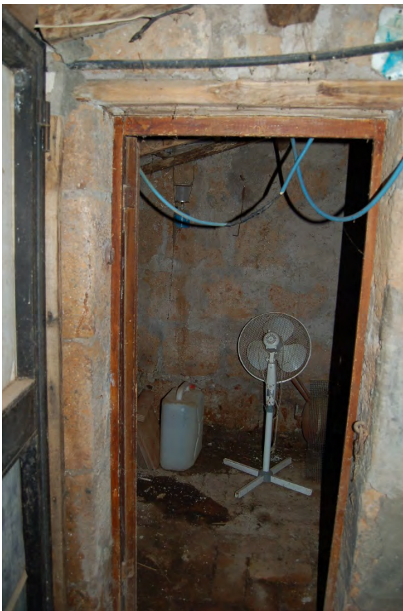
Foto 41- Vista interna del magazzino –ambiente 2
