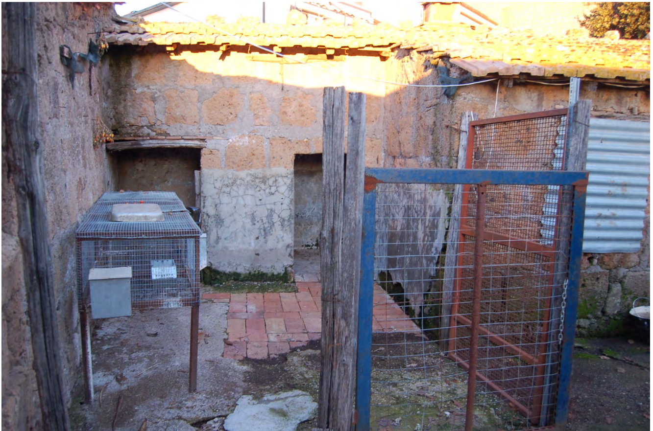
Foto 44 - Vista della porcilaia adiacente al magazzino
