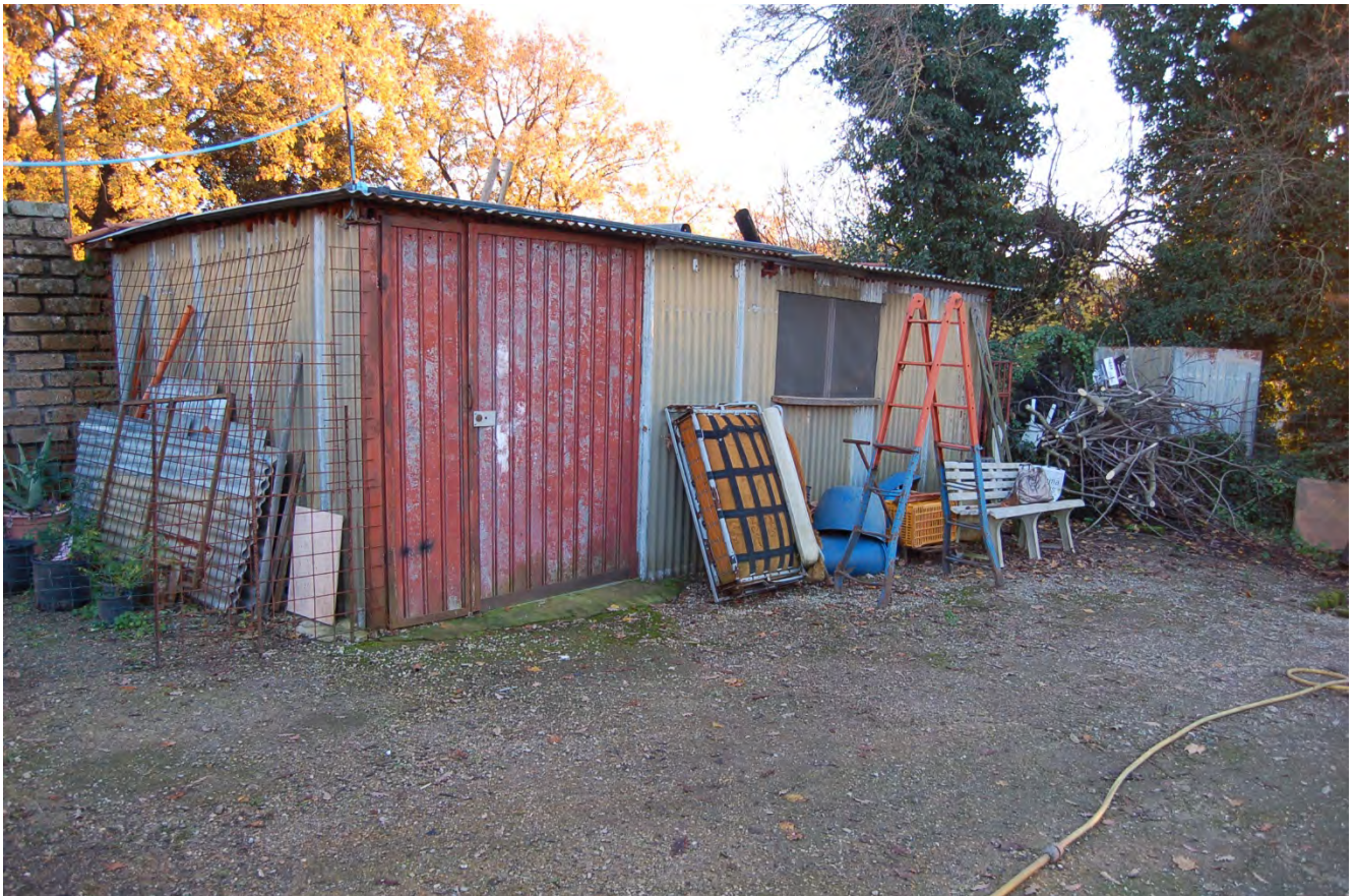
Foto 34 - Ex fabbricato rurale, attualmente baracca
