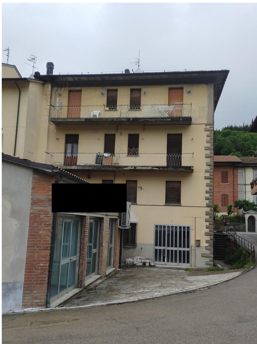
- FACCIATA TERGALE VIA S. ROCCO -
