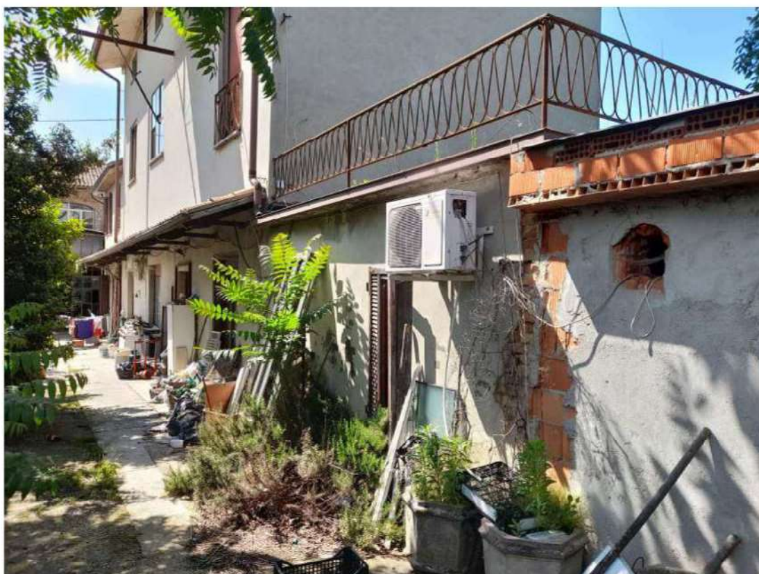
FOTO 4 - ALTRA VEDUTA DAL CORTILE INTERNO
