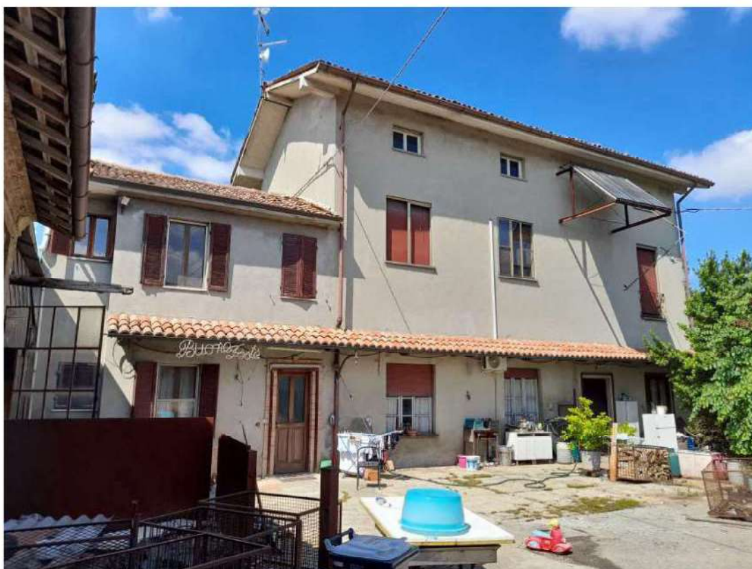
FOTO 2 - VEDUTA DAL CORTILE DEL PROSPETTO PRINCIPALE
