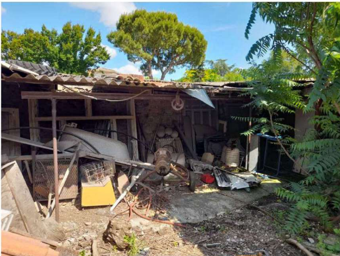
FOTO 6 - TETTOIA NEL CORTILE
