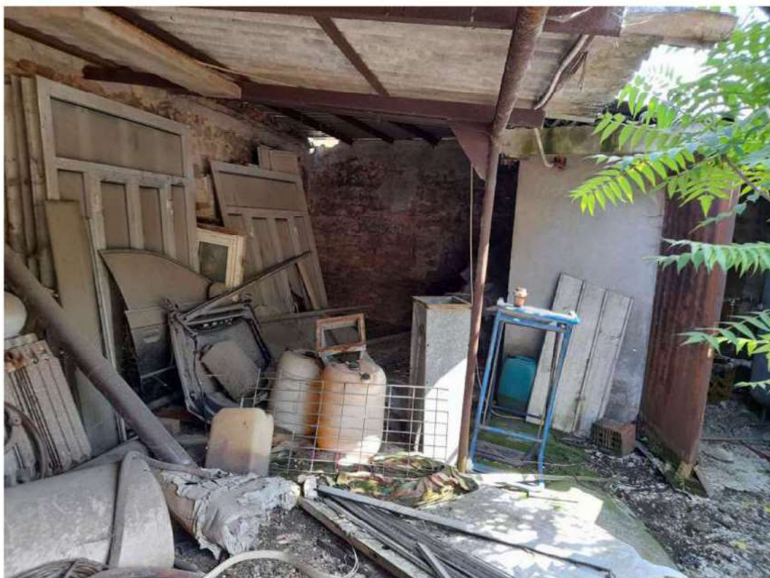
FOTO 10 - TETTOIA NEL CORTILE
