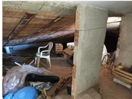
particolare locale sottotetto
