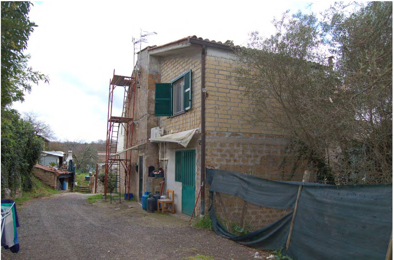
Foto 6 - Vista d'insieme del fabbricato distinto al catasto al fg.60 part.540
