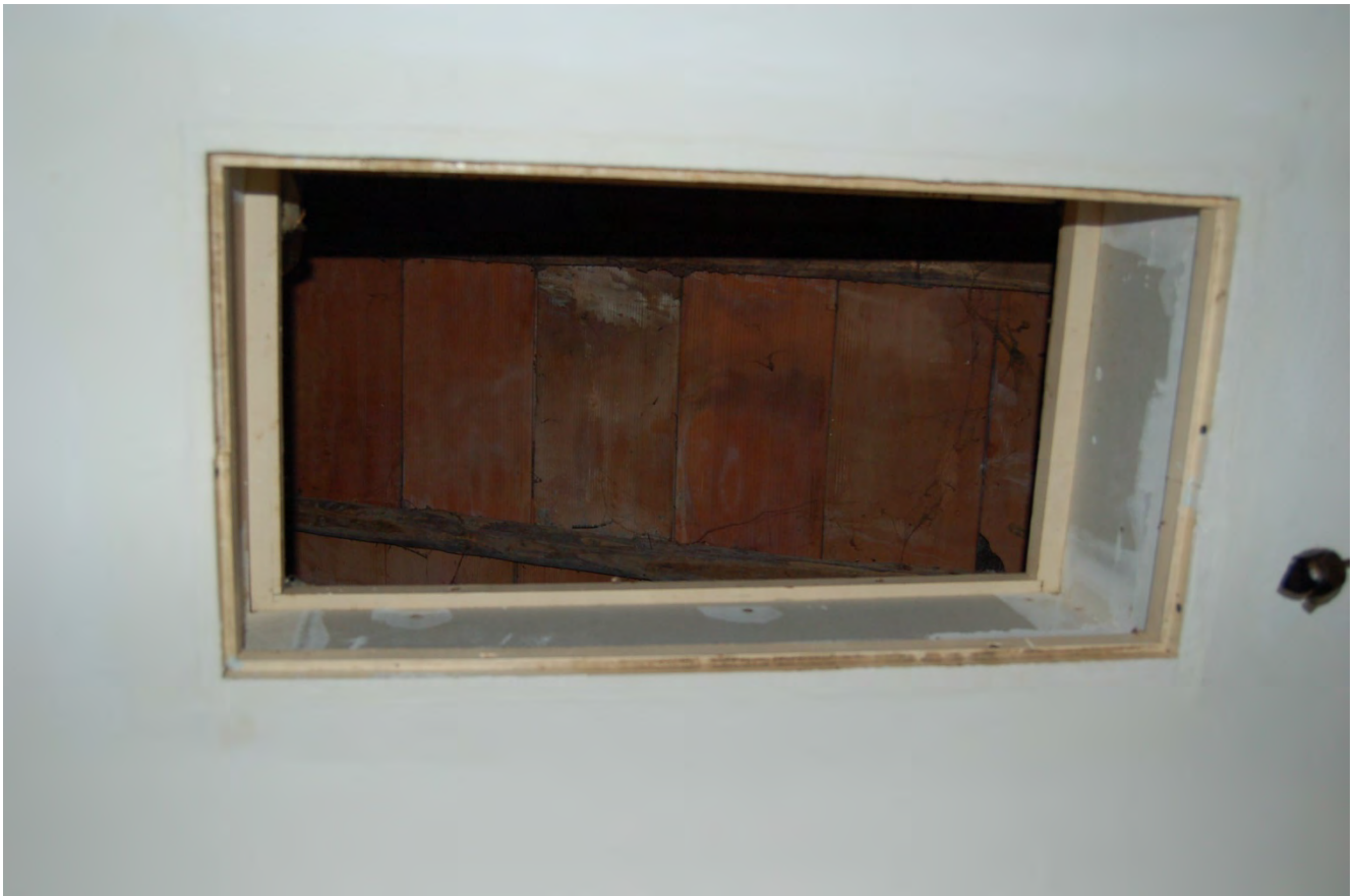
Foto 20 - Dettaglio della botola
