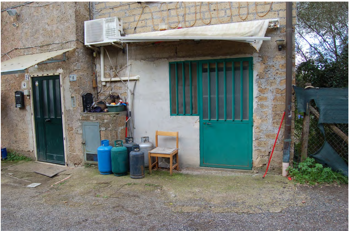
Foto 21 - Vista esterna del garage
