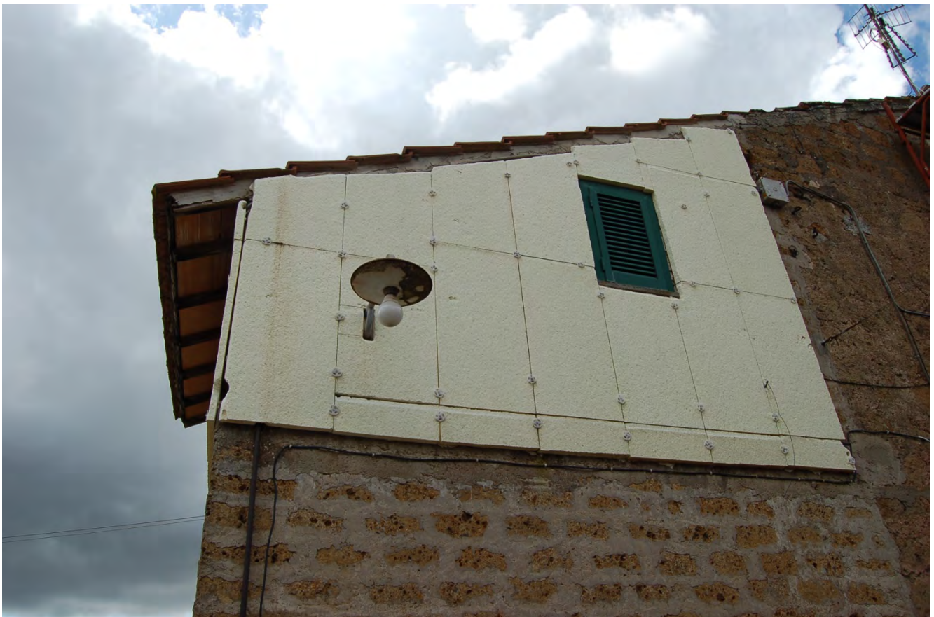
Foto 5 - Vista esterna di dettaglio dell'unità immobiliare
