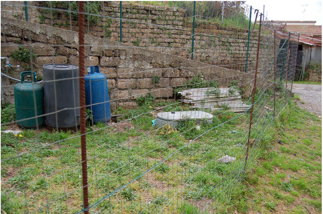
Foto 28 - Vista di dettaglio dell'area esterna
