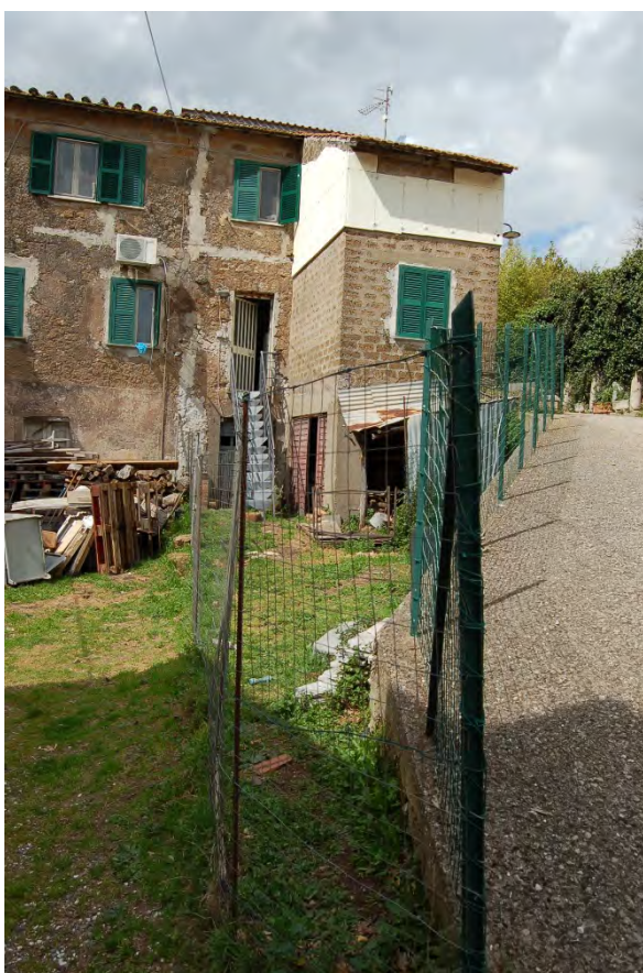
Foto 27 - Vista dell'area di pertinenza esterna
