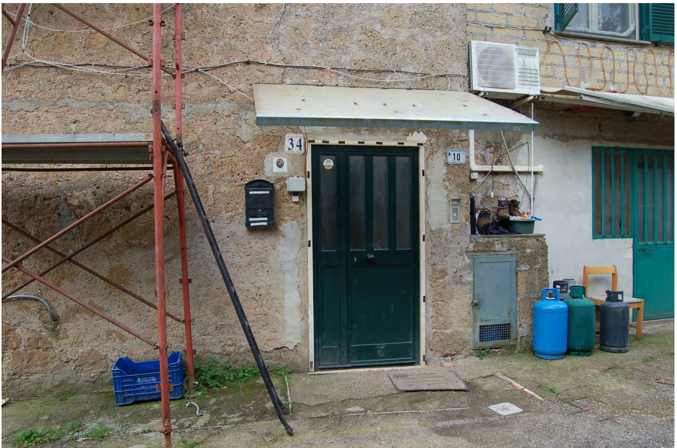
Foto 7 - Vista di dettaglio dell'ingresso su Via Quattro Faggi, 10
