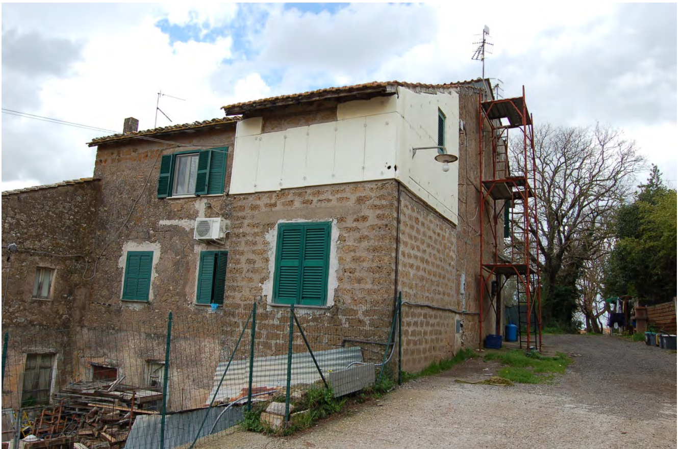
Foto 3 – Vista d'insieme del fabbricato distinto al catasto al fg.60 part.540
