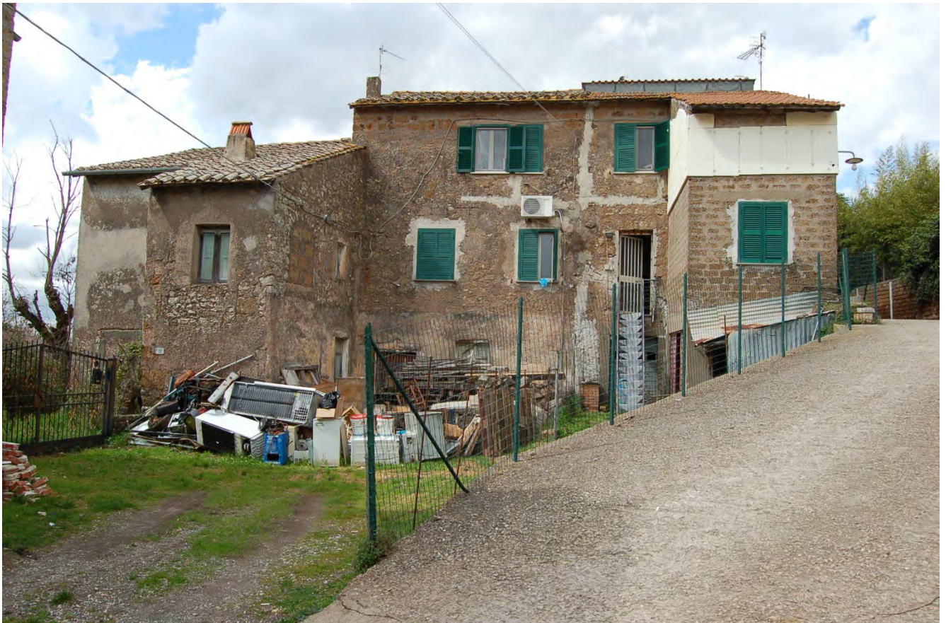
Foto 2 – Vista d'insieme del fabbricato distinto al catasto al fg.60 part.540
