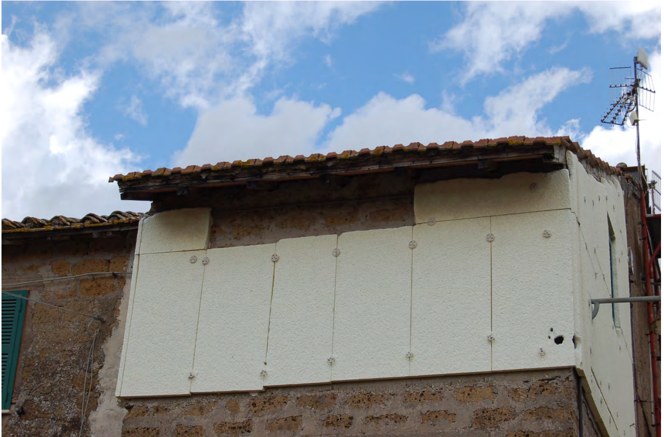
Foto 4 - Vista esterna di dettaglio dell'unità immobiliare
