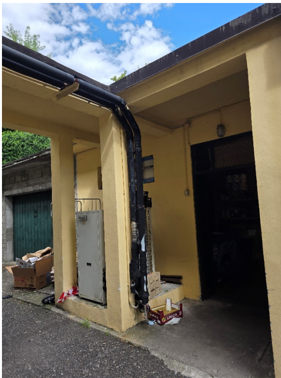
Foto 2 - Vista accesso magazzino 4385 sub.1.
