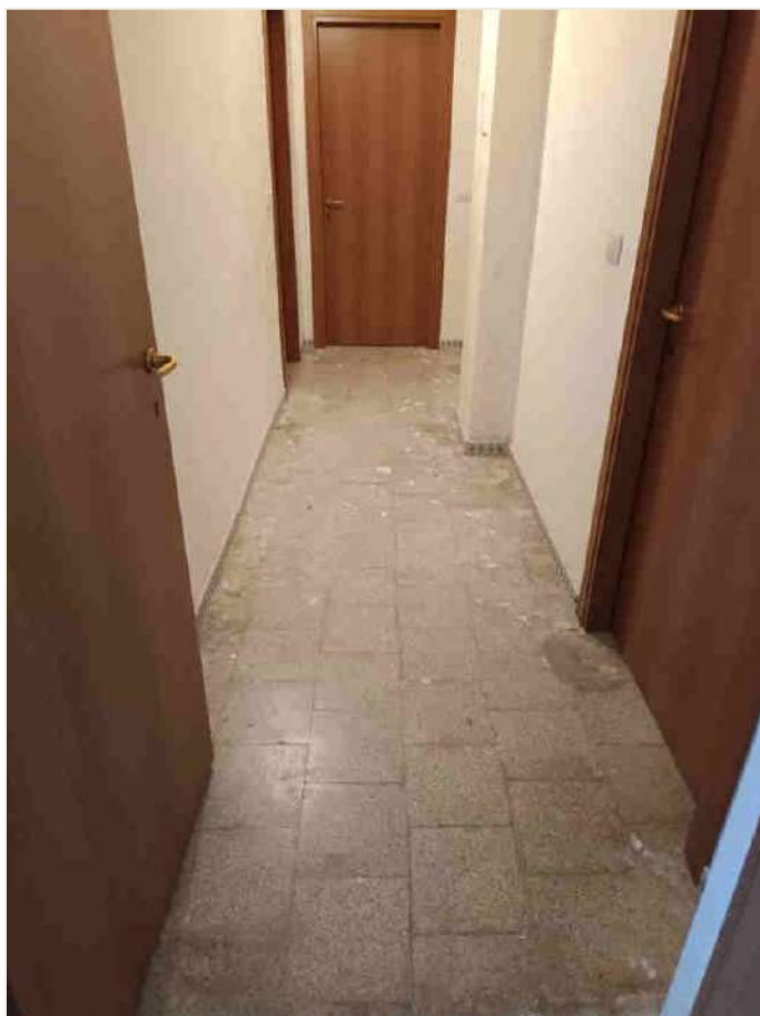
Foto 3 (vista corsia di accesso da androne a box )
