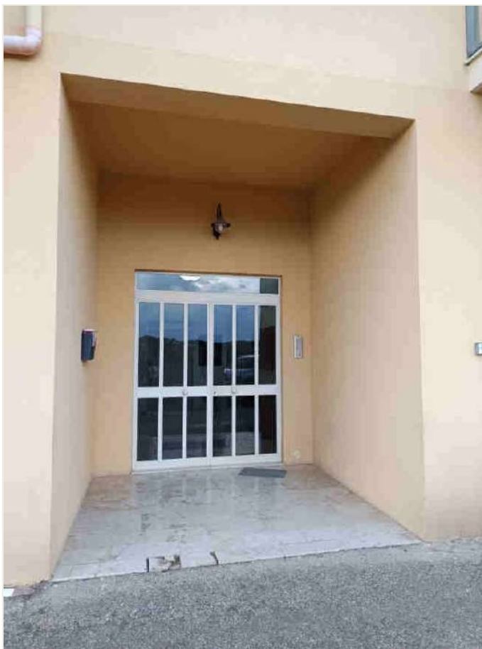
Foto 1 (vista portone ingresso principale)
