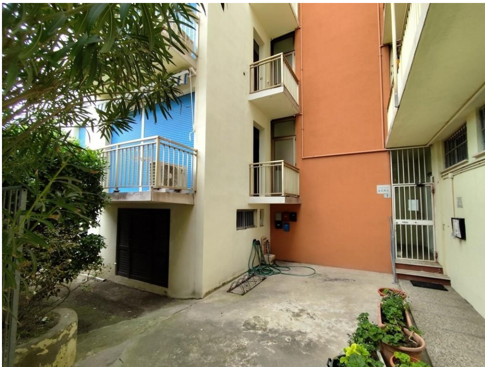
0.3 – vista da Sud-Ovest (via Adamello)
