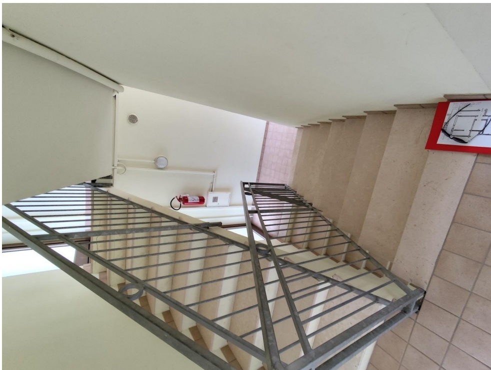
0.8 – vano scala condominiale
