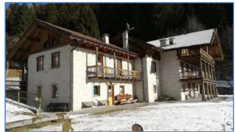
intercapedine a monte dell'edificio
