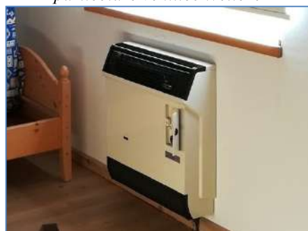
particolare ventilconvettore
