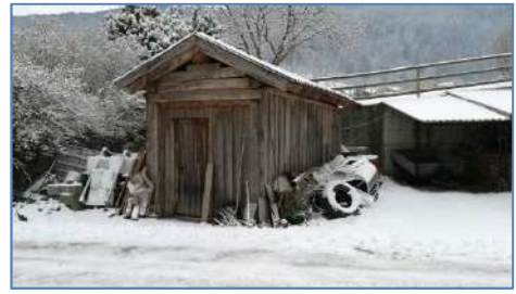
vista baracca zona pozzo
