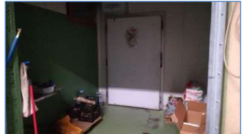
portoni entrata visti da esterno
