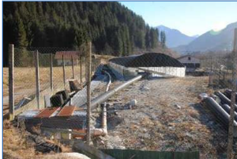
vista ultimo tratto della tubazione
