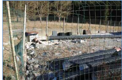
particolare ultimo tratto tubazione
