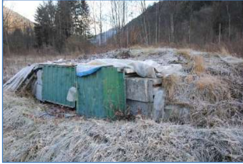
vista manufatto pozzo 1
