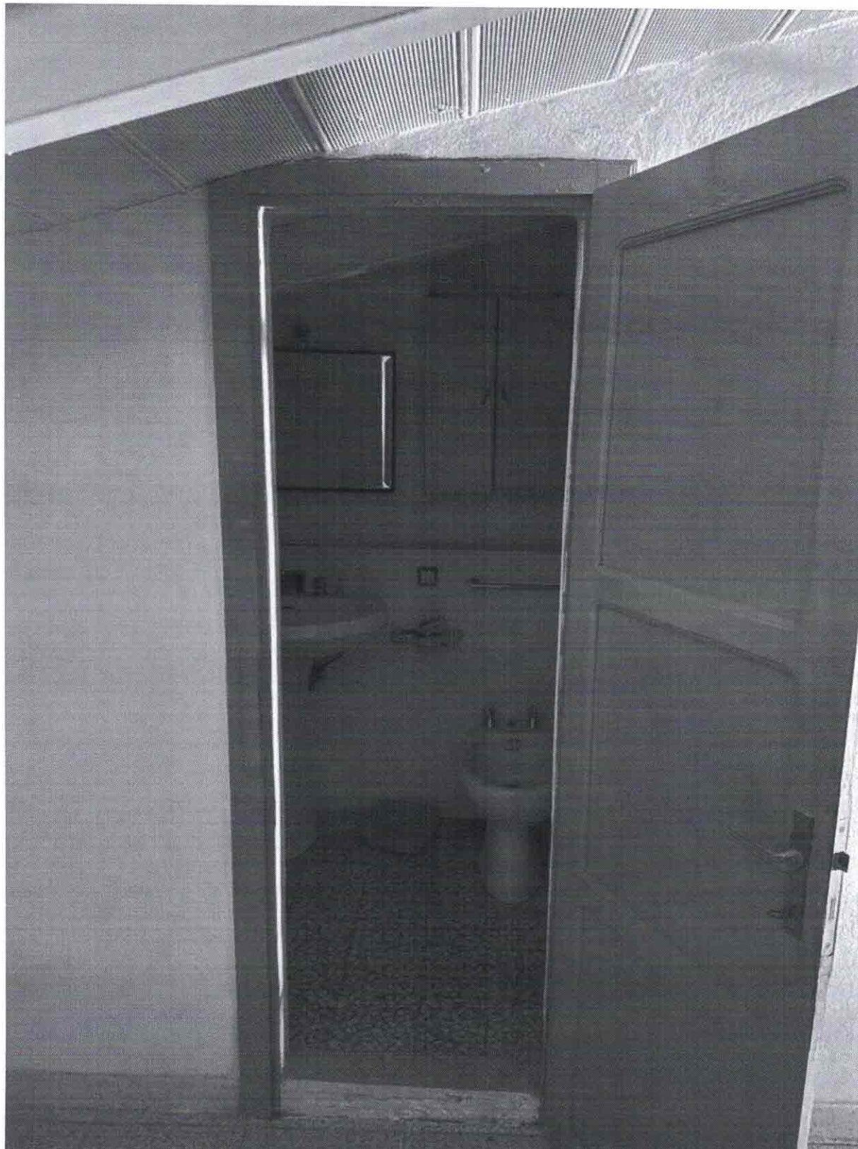
Foto 22 Porta d'ingresso del bagno nel Sottotetto
