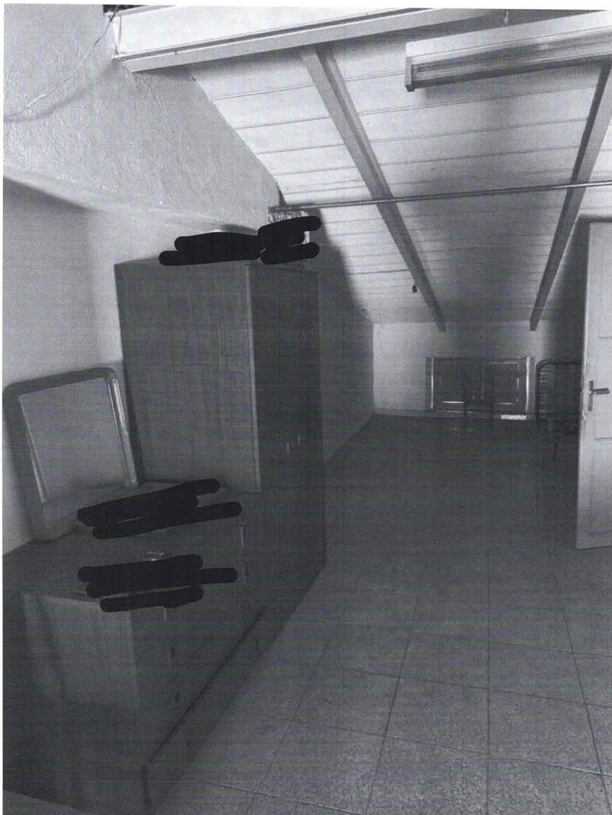
Foto 20: Sottotetto con solaio in legno a due falde e finestrella lato sud
