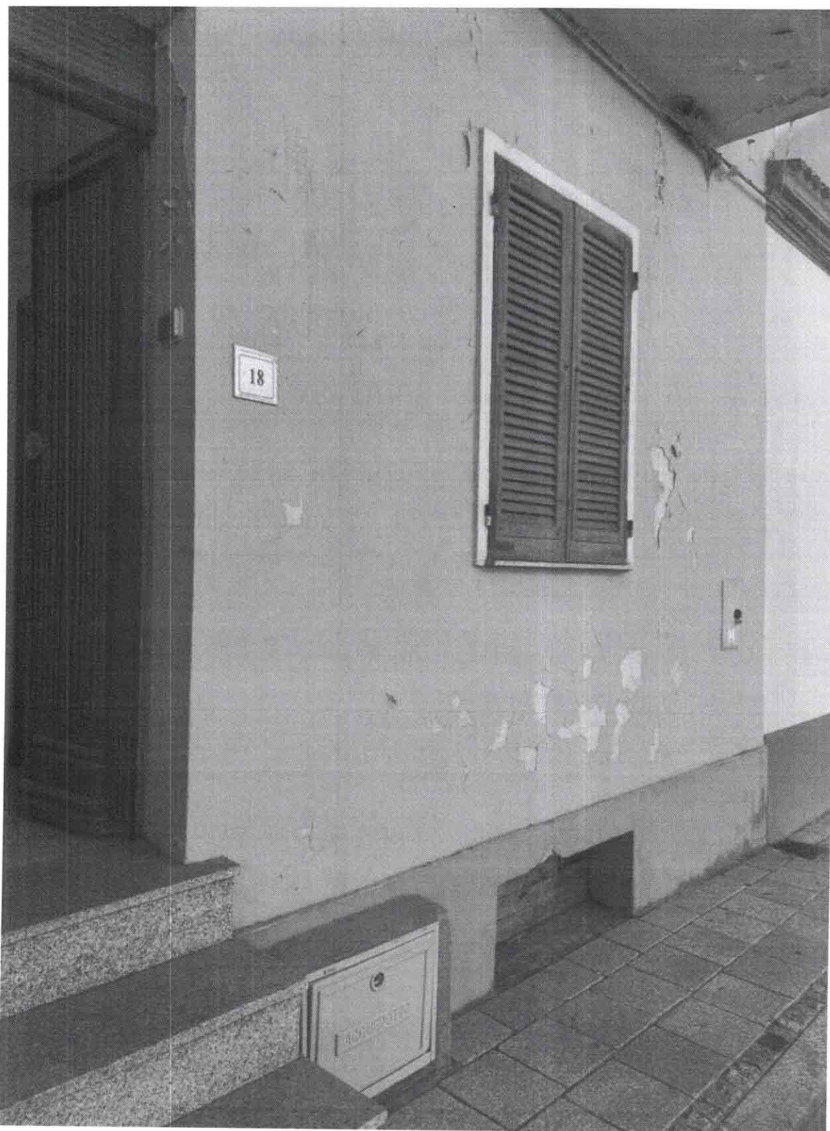
Foto 2: Facciata lato nord dell'abitazione e finestra della Cucina
