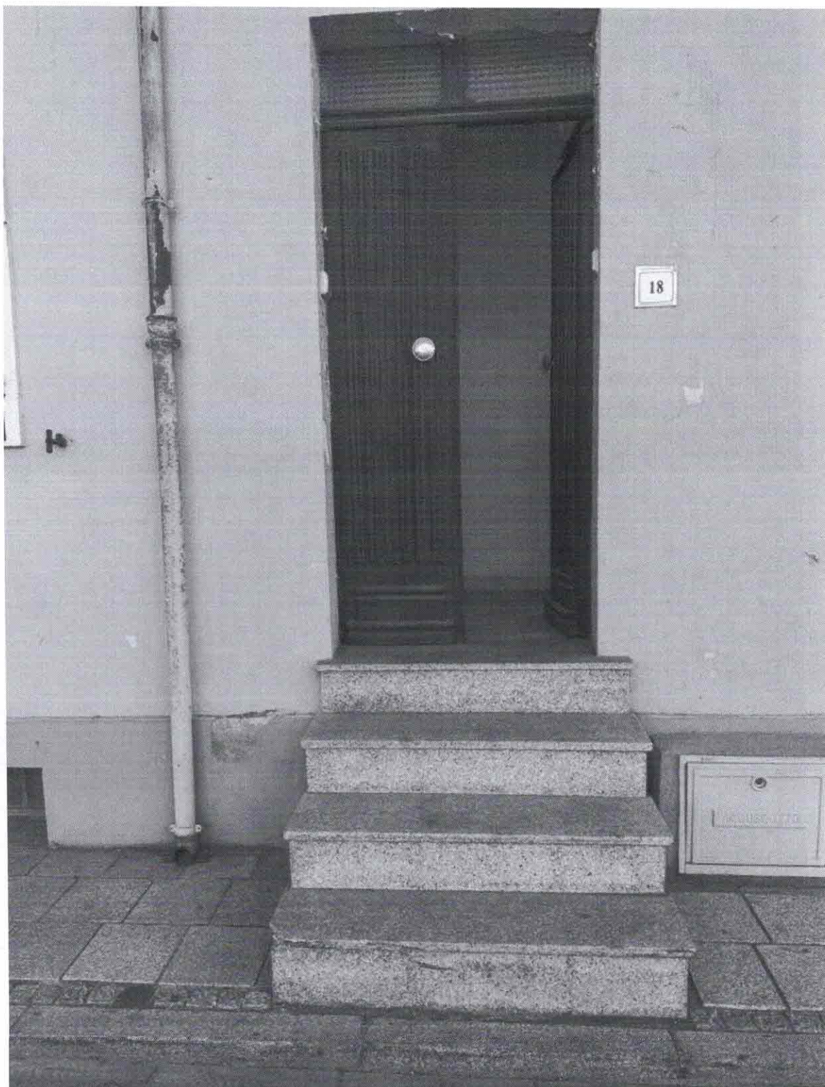
Foto 1: Portone d'ingresso comune alle due abitazioni
