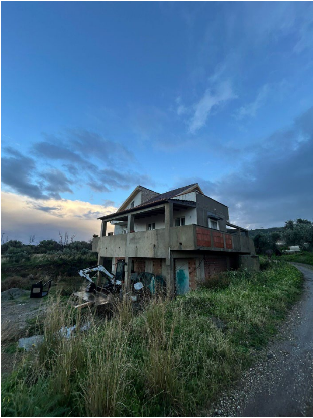
Figura 1 – Vista esterna immobile
