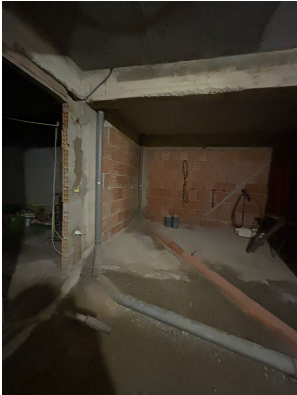
Figura 5 - Locale deposito seminterrato
