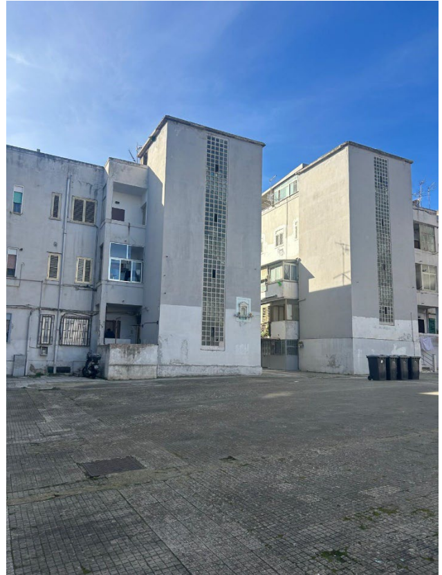
Figura 2 - Cortile interno Isolato 12bis
