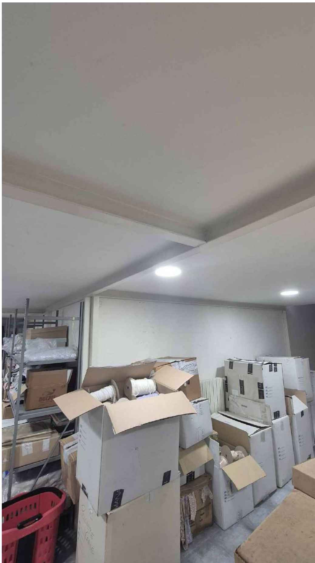
TRIBUNALE DI TRANI – FOTO SOPRALLUOGO OPERAZIONI PERITALI
