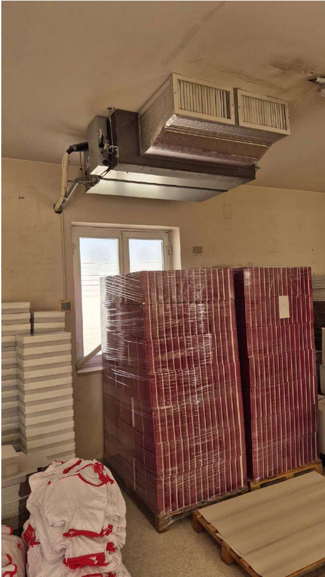
TRIBUNALE DI TRANI – FOTO SOPRALLUOGO OPERAZIONI PERITALI
