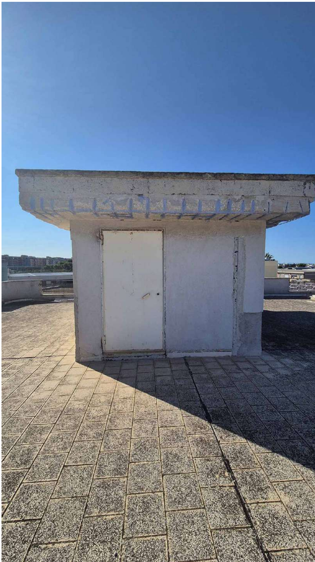
TRIBUNALE DI TRANI – FOTO SOPRALLUOGO OPERAZIONI PERITALI
