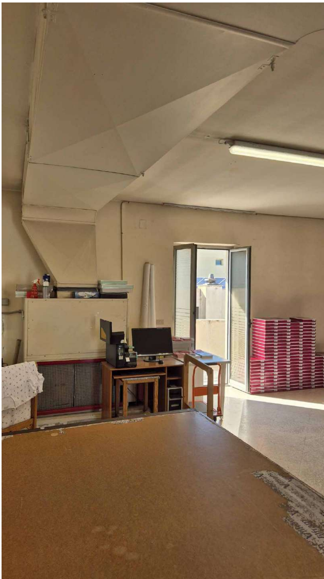
TRIBUNALE DI TRANI – FOTO SOPRALLUOGO OPERAZIONI PERITALI
