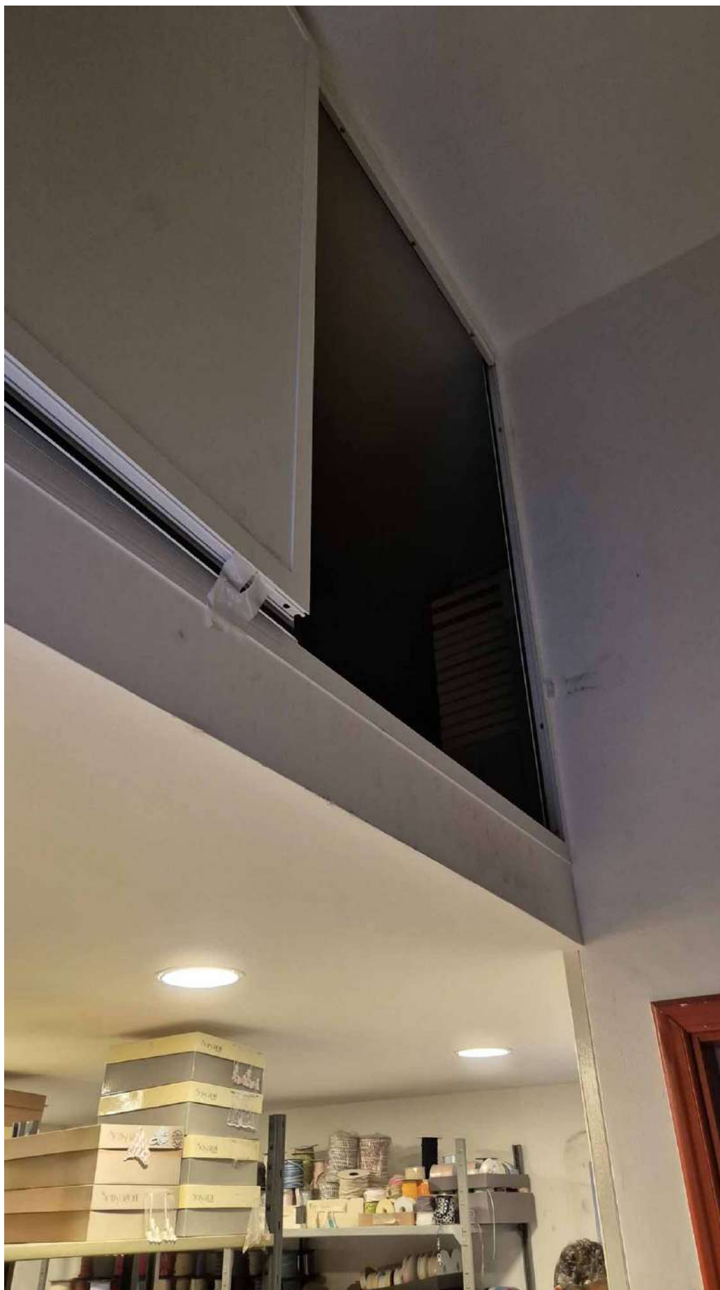
TRIBUNALE DI TRANI – FOTO SOPRALLUOGO OPERAZIONI PERITALI
