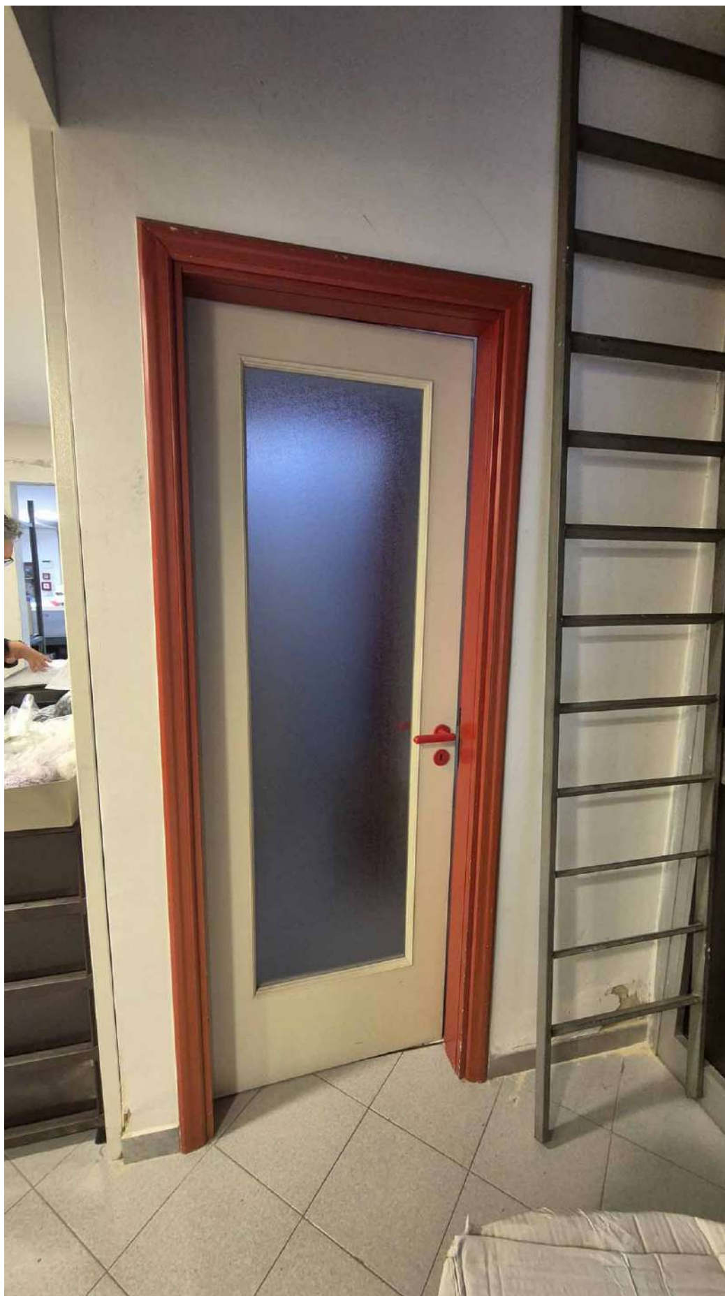
TRIBUNALE DI TRANI – FOTO SOPRALLUOGO OPERAZIONI PERITALI
