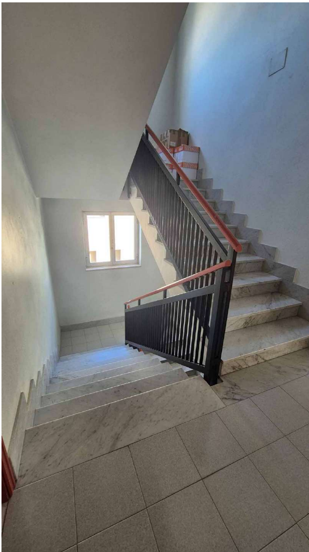
TRIBUNALE DI TRANI – FOTO SOPRALLUOGO OPERAZIONI PERITALI
