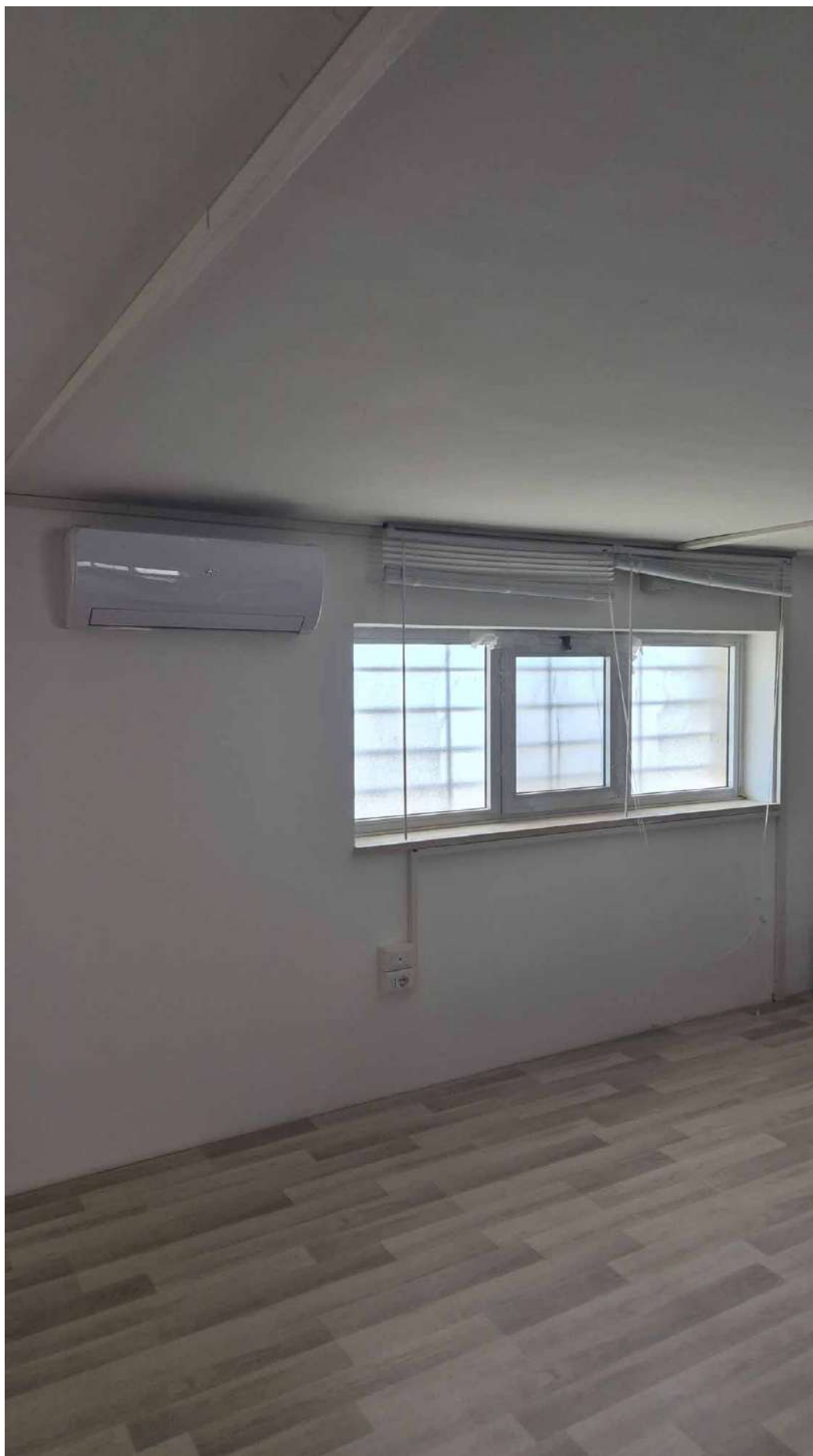
TRIBUNALE DI TRANI – FOTO SOPRALLUOGO OPERAZIONI PERITALI
