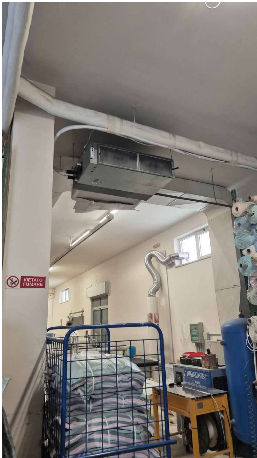
TRIBUNALE DI TRANI – FOTO SOPRALLUOGO OPERAZIONI PERITALI
