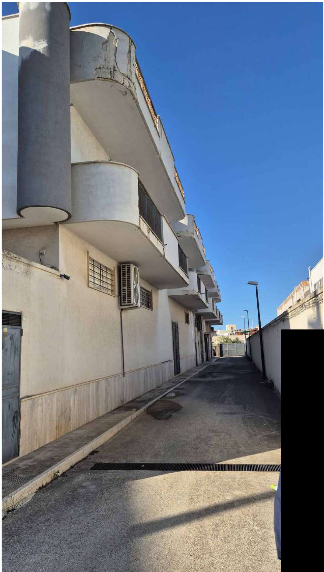
TRIBUNALE DI TRANI – FOTO SOPRALLUOGO OPERAZIONI PERITALI
