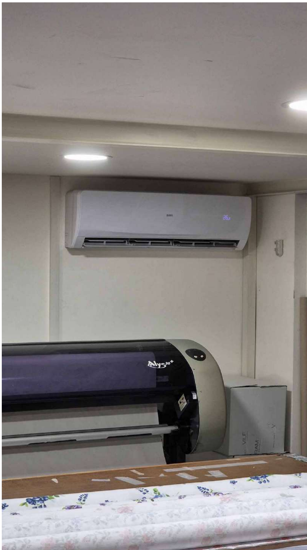
TRIBUNALE DI TRANI – FOTO SOPRALLUOGO OPERAZIONI PERITALI
