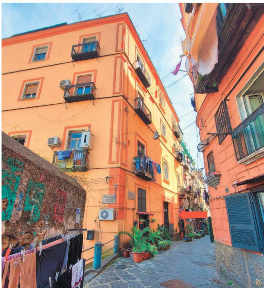
Prospetto sud fabbricato –via san Mandato - indicazione affacci cespite e accesso civ.67
