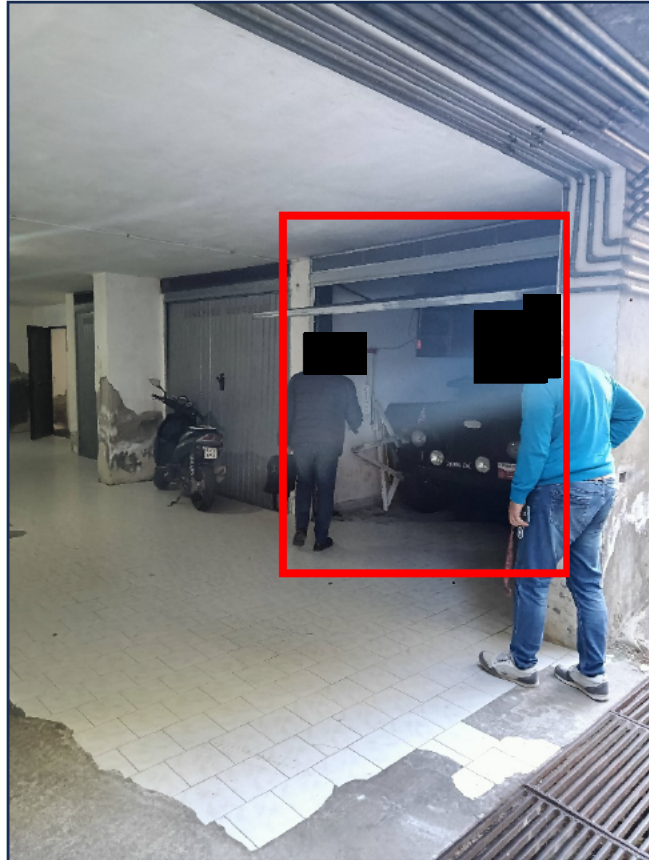
3.6 - Vista esterna box auto – piano interrato
