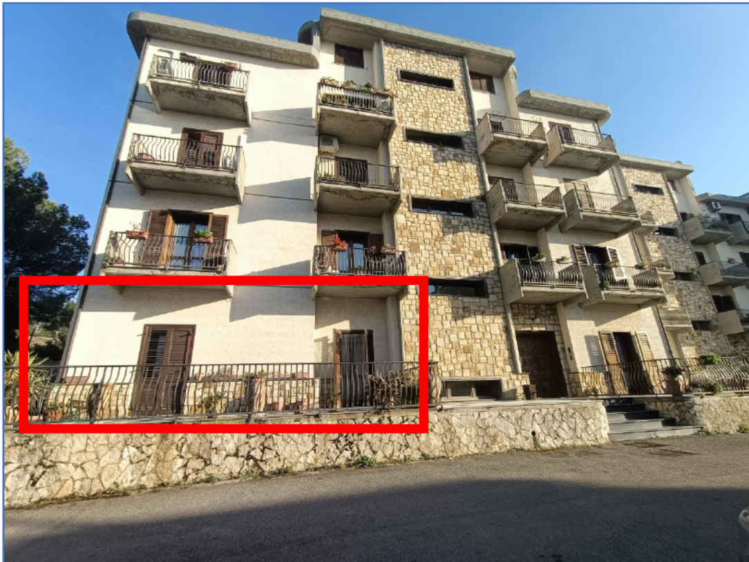
3.1 - Vista esterna appartamento – fronte lato ingresso
