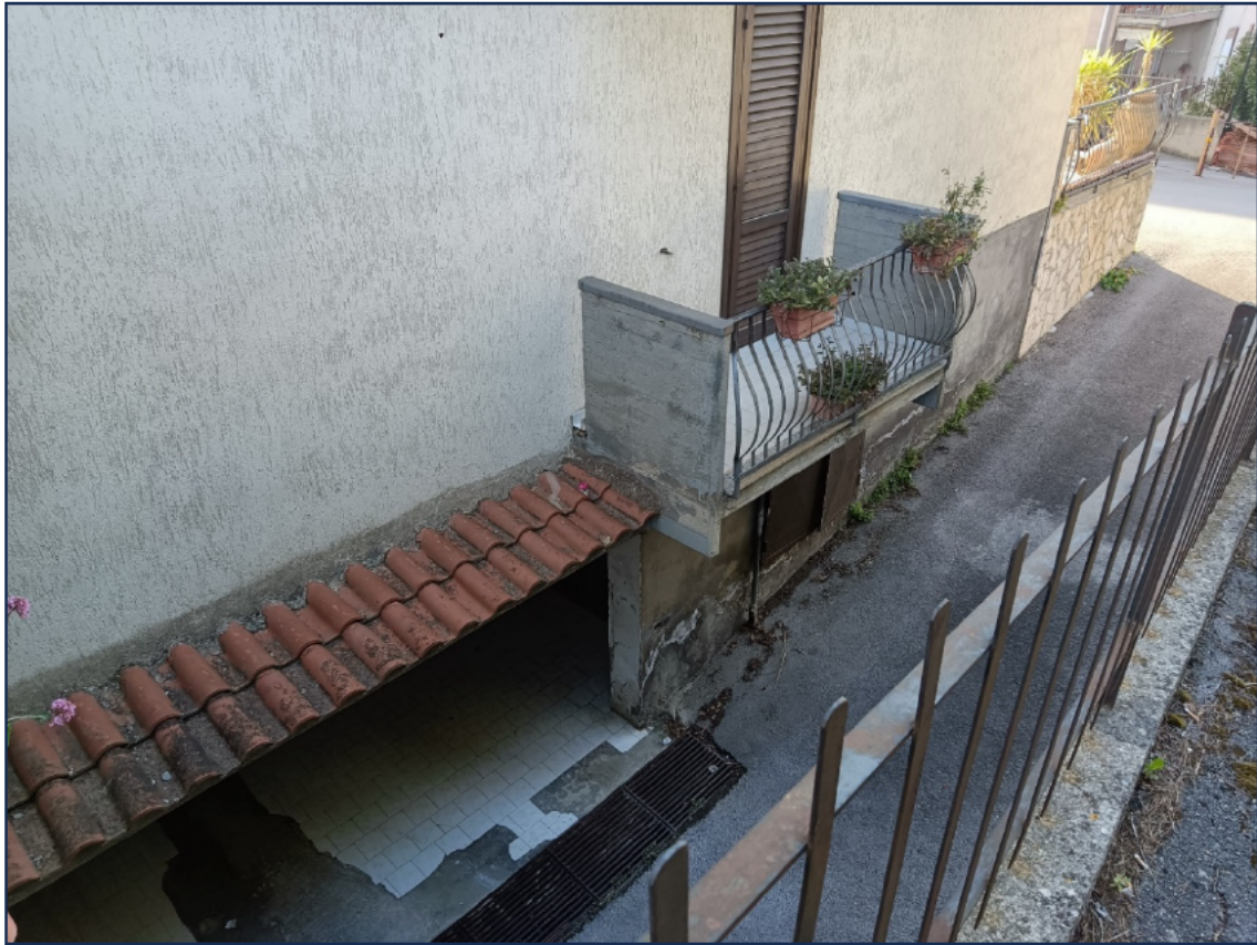
3.5 - Vista esterna appartamento – prospetto laterale con balcone e rampa accesso box auto
