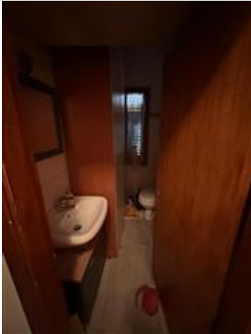
bagno piano primo
