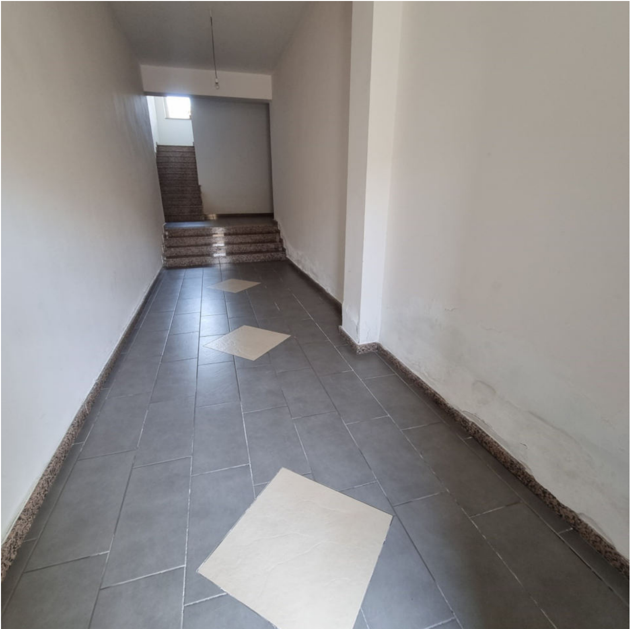
Foto 20240209_110825 – Ingresso/vano scala condominiale
