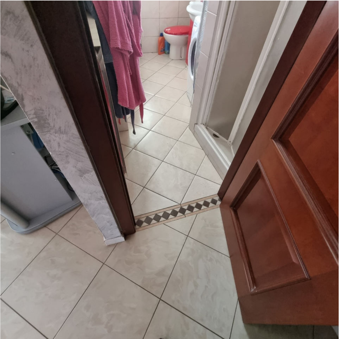
Foto 20240209_104413 – Porta di accesso Lavanderia
