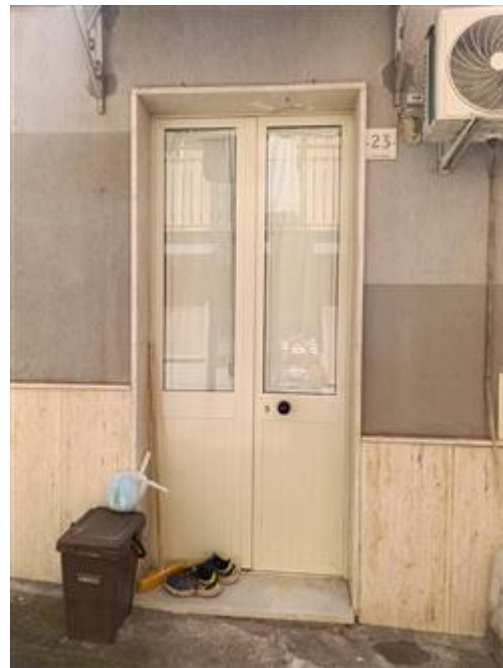
Vista della porta-finestra della cucina
