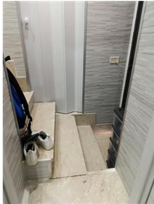
Vista del collegamento interno
