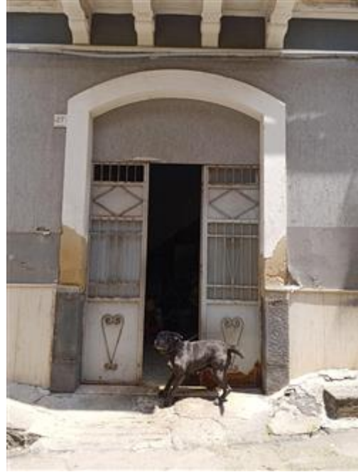
Ingresso al garage
