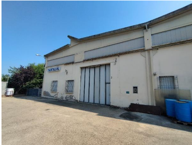
Capannone via G. Bovio n.1/b - sub.25
