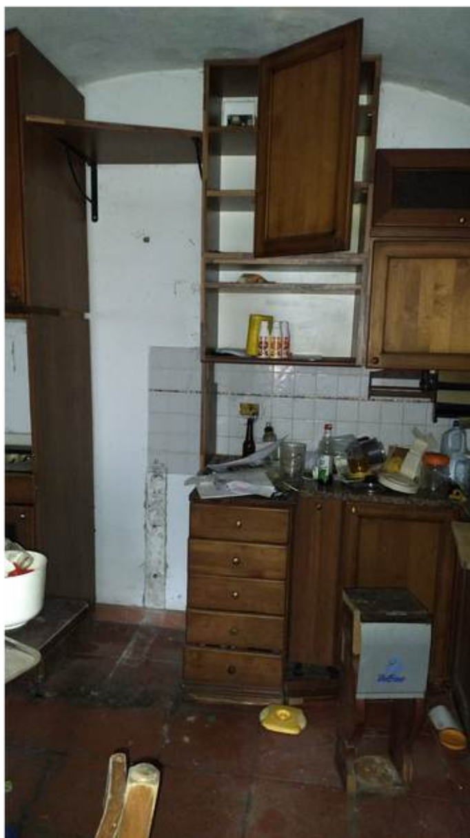
F.30 - Vista dei locali
