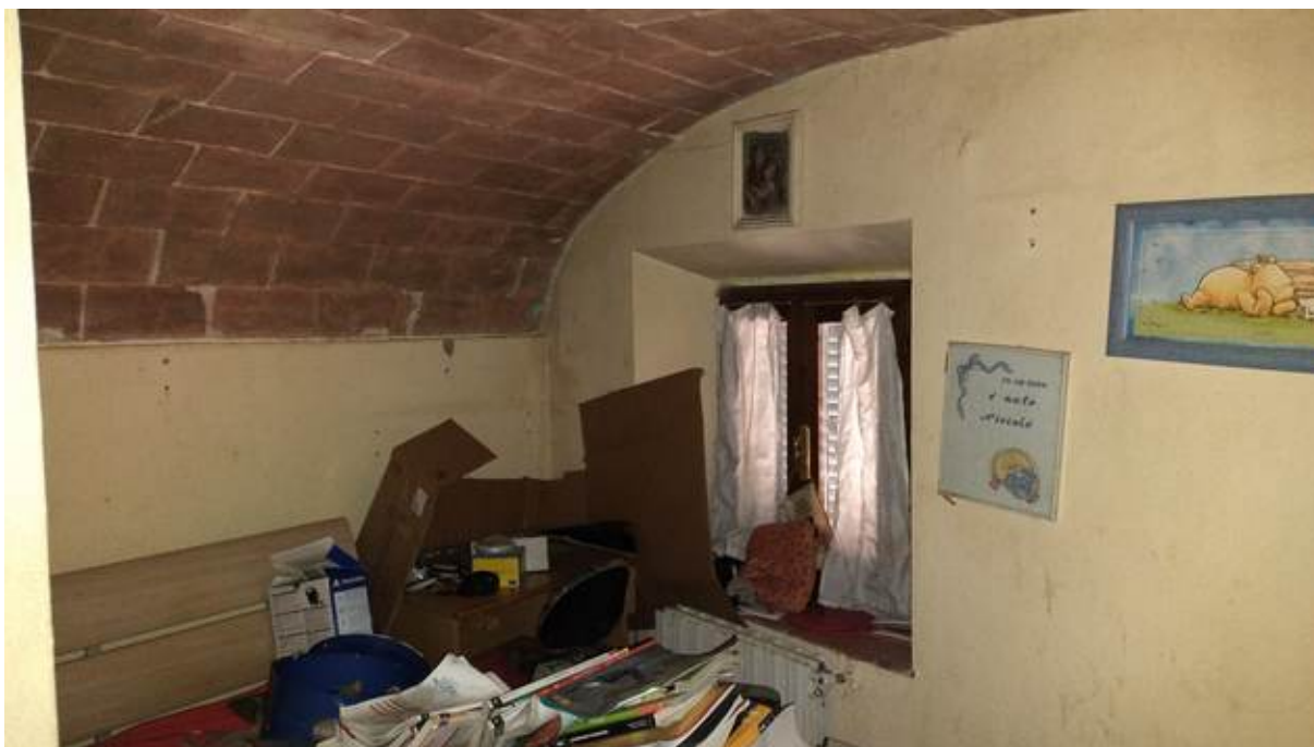
F.31 - Vista dei locali
