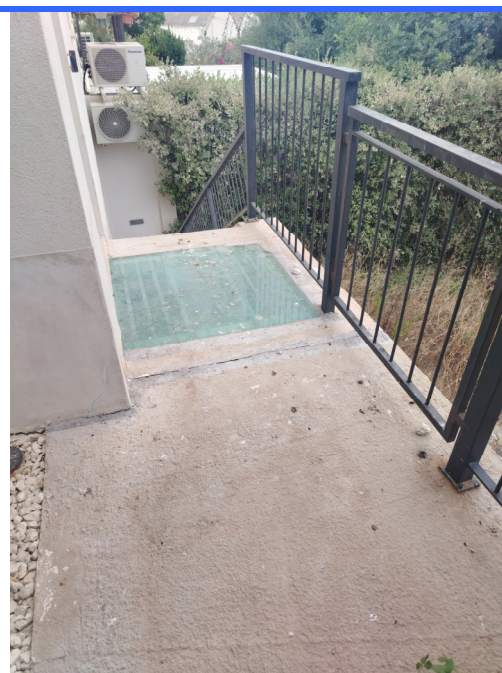
FIGURA 10: PIANO TERRA – ballatoio esterno
