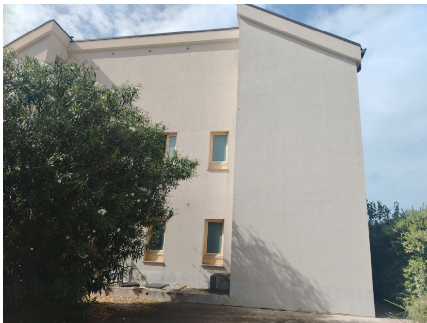
FOTO 1: Prospetto nord est
