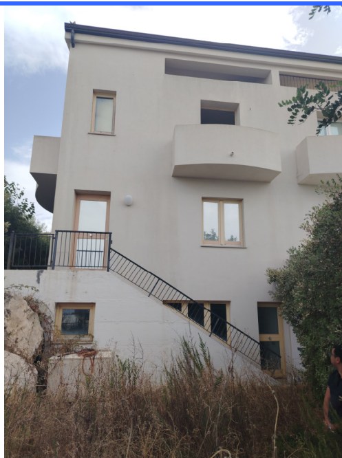
FOTO 2: prospetto sud ovest
