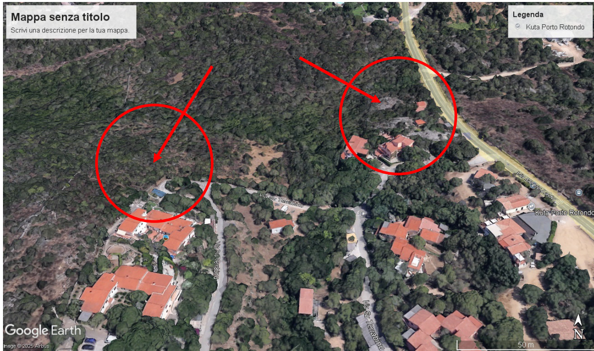
Vista Aerea - Ubicazione LOTTO N. 1 E LOTTO N. 2
