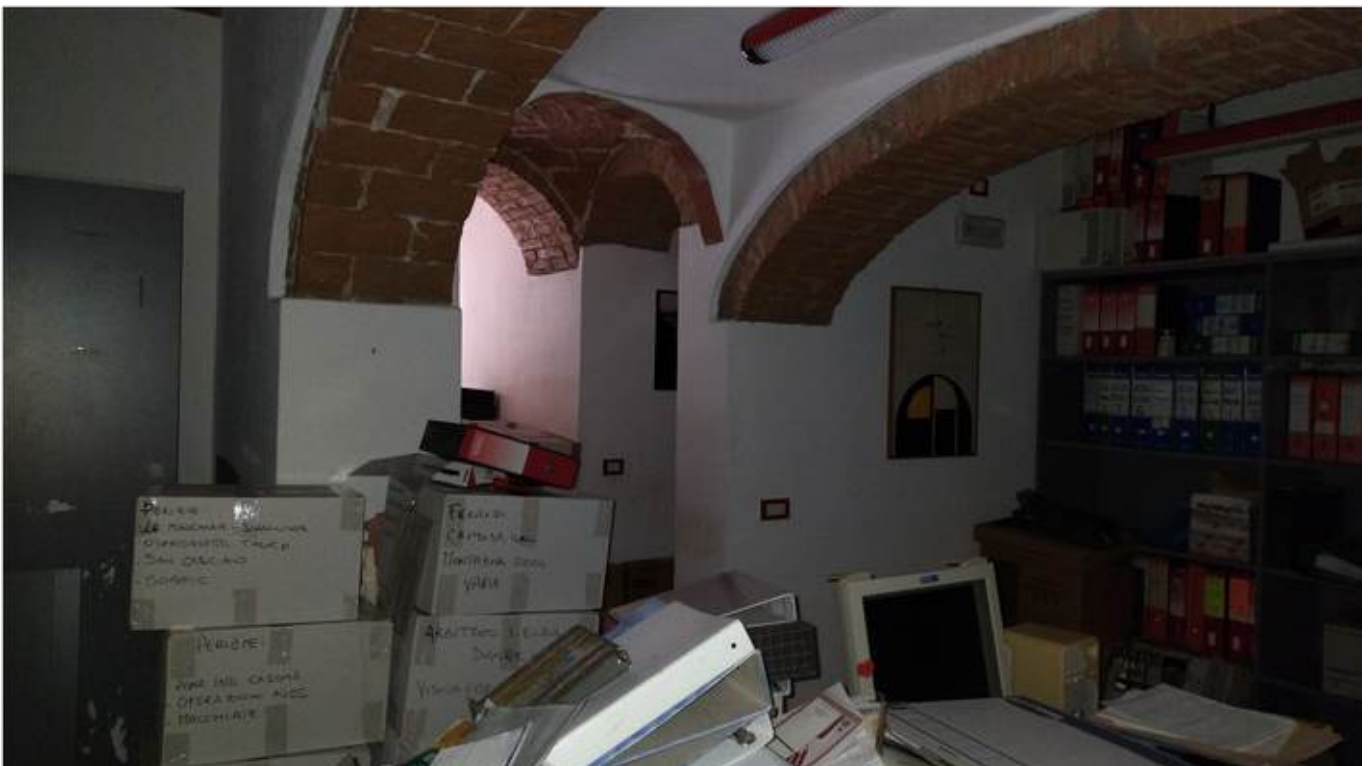
F.14 – Vista interna dei locali
