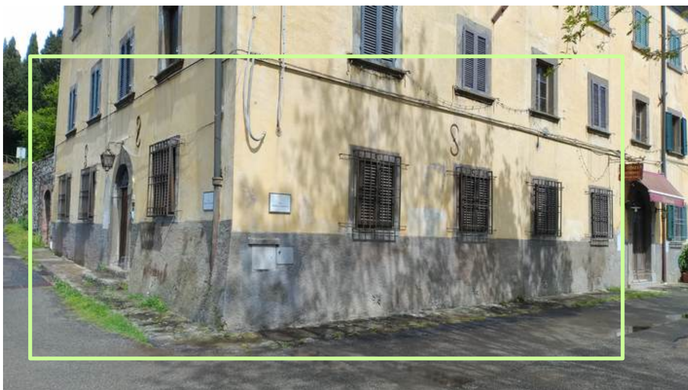
F.10 – Vista esterna dell'ufficio
