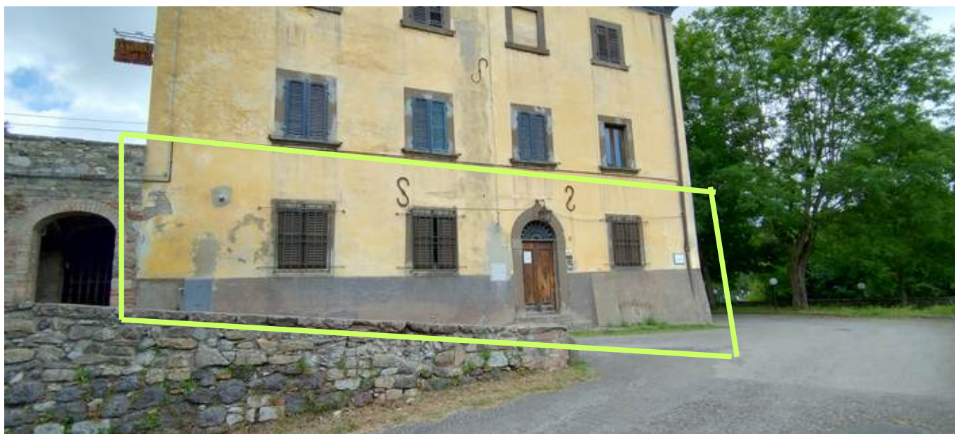
F.9 – Prospetto con ingresso esclusivo
