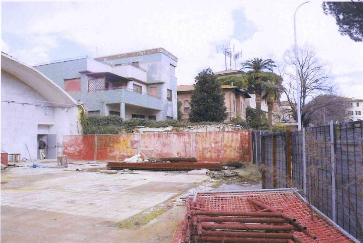
8. Altra veduta delle porzioni residuali del capannone preesistente.
