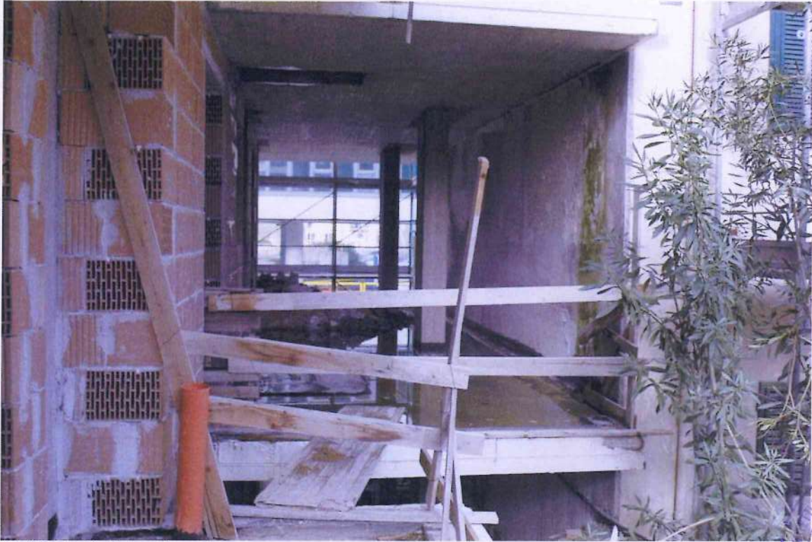
19. Altra veduta del cantiere.
