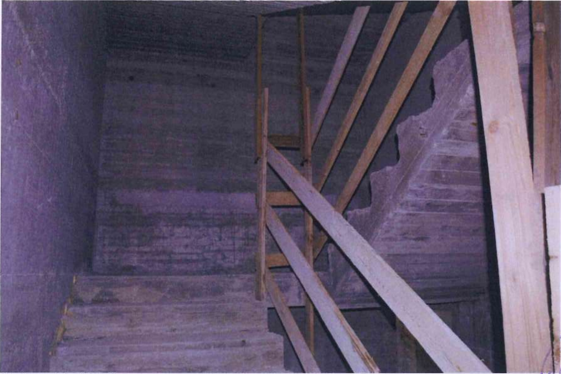
17. Altra veduta del cantiere.
