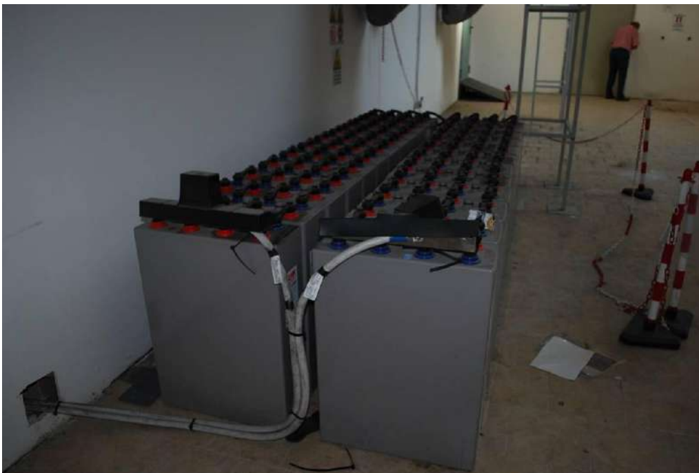
20. Interni piano terra (ex FASTWEB)
