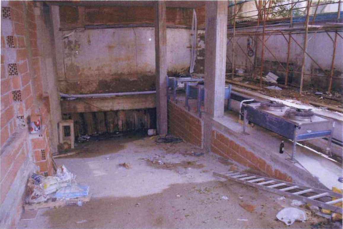
9. Veduta della rampa garages.
