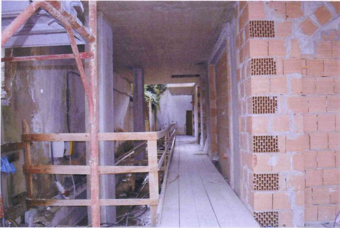
13. Veduta del cantiere.
