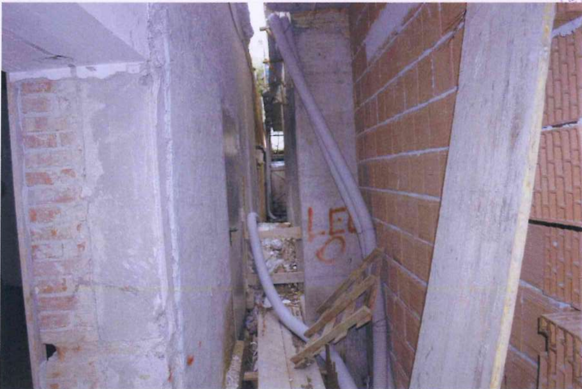
16. Altra veduta del cantiere.
