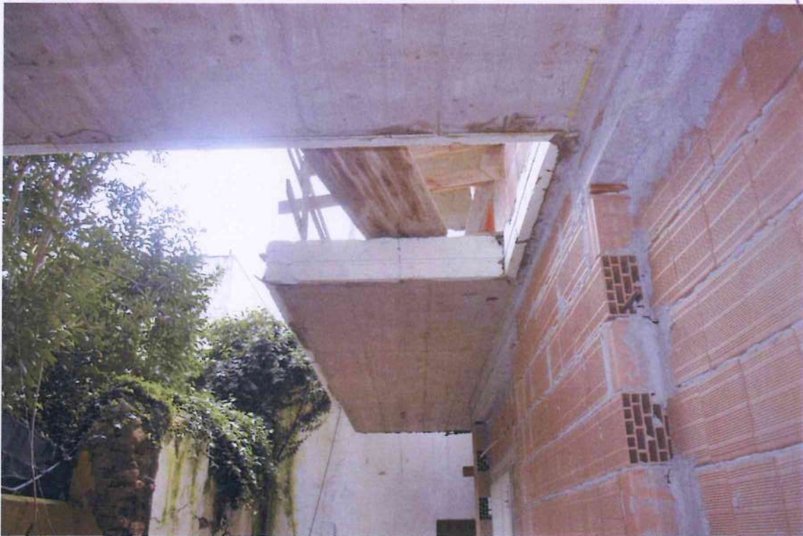
14. Altra veduta del cantiere.
