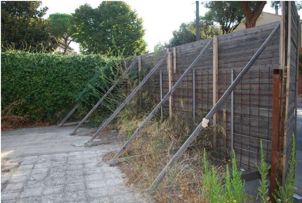
14. Recinzione provvisoria di Via Manetti
