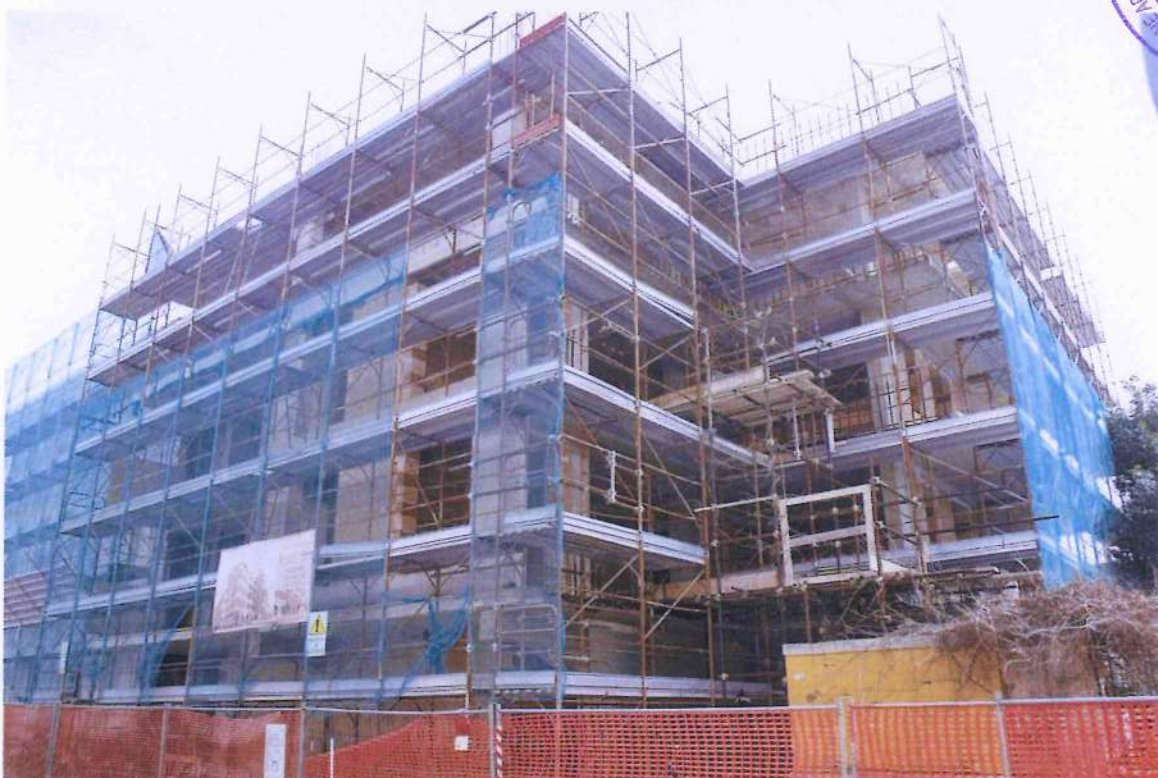
2. Porzione di fabbricato in corso di realizzazione. Altra veduta del fabbricato da Via Bonghi.
