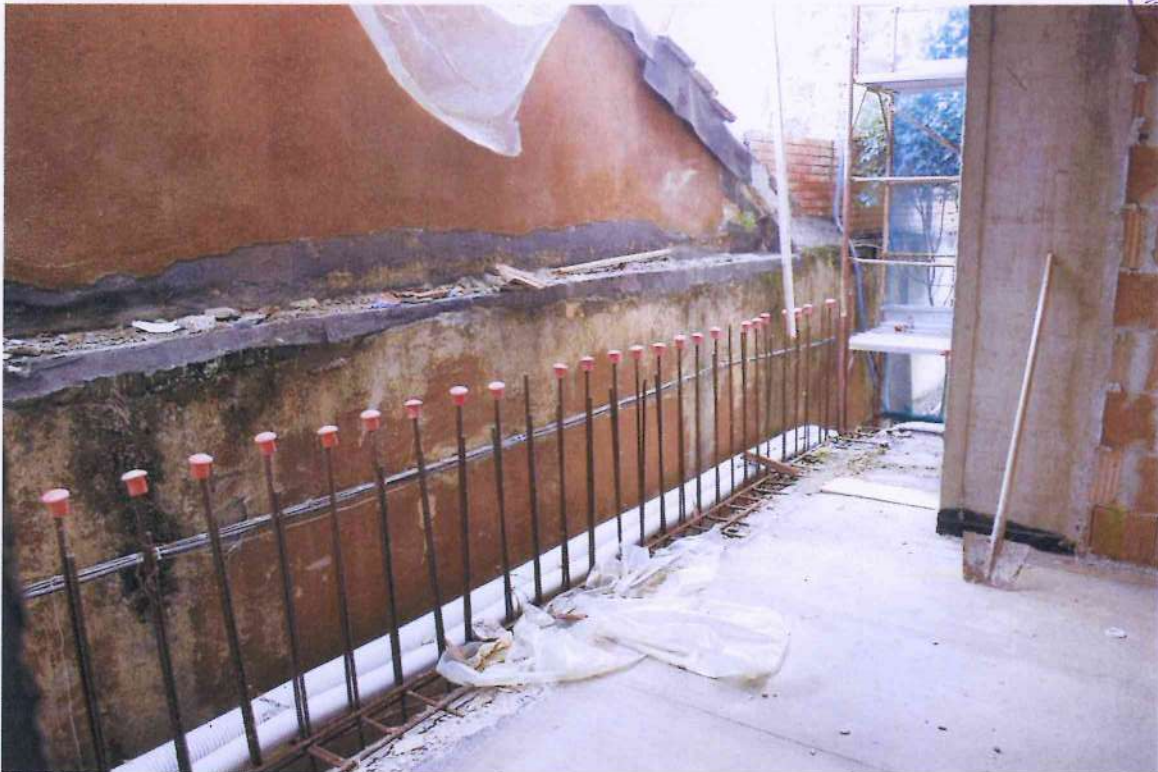
18. Altra veduta del cantiere.
