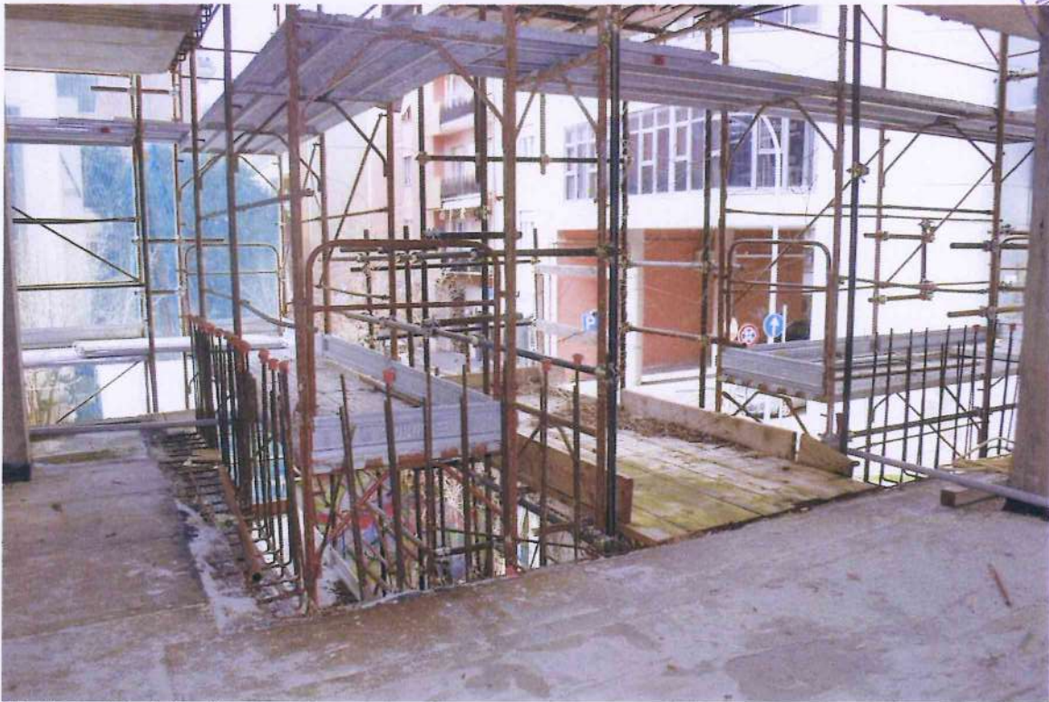
20. Altra veduta del cantiere.
