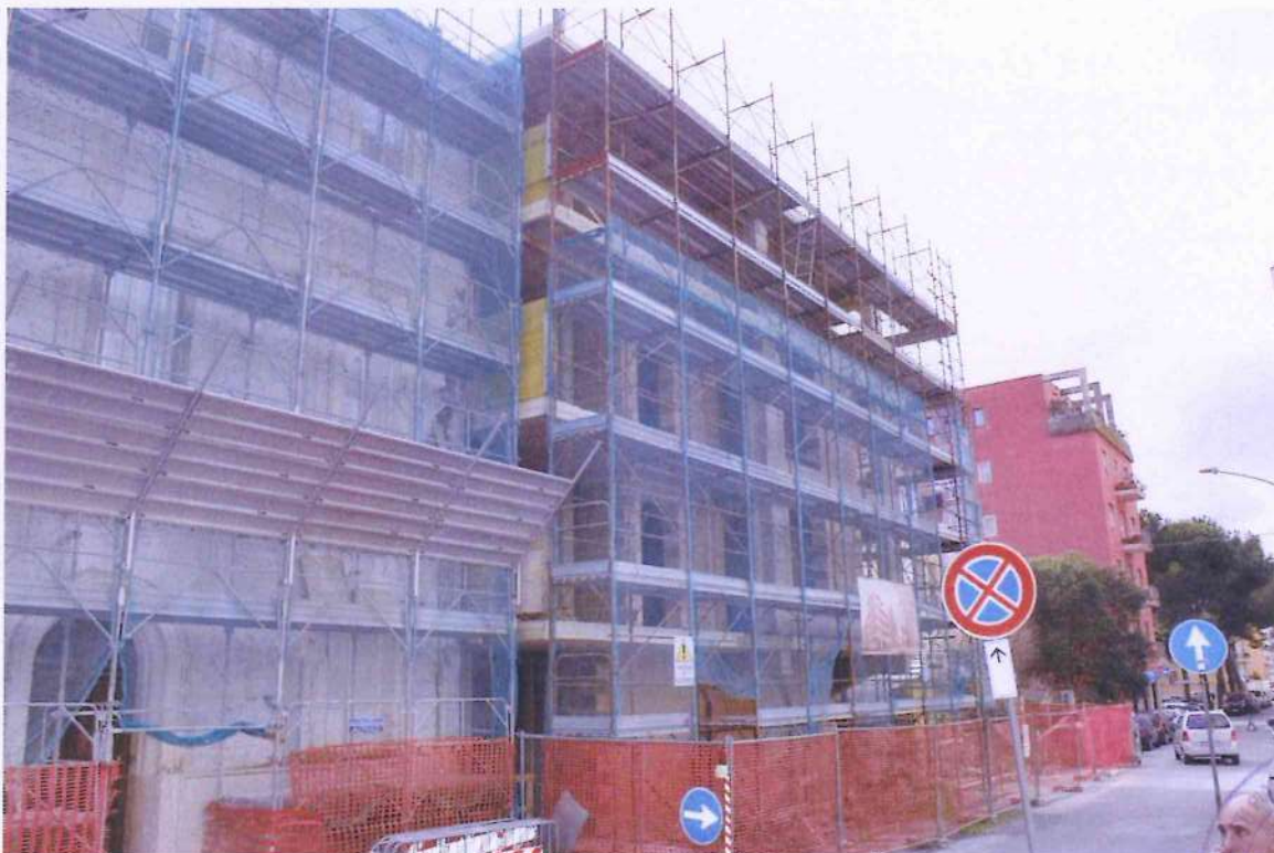
3. Porzione di fabbricato in corso di realizzazione. Altra veduta del fabbricato da Via Bonghi
