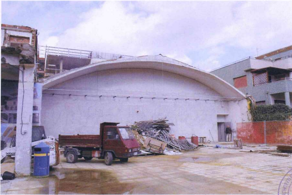
7. Altra veduta delle porzioni residuali del capannone preesistente.
