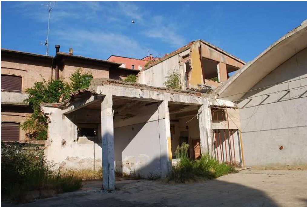
15. Piazzale di accesso di Via Manetti
