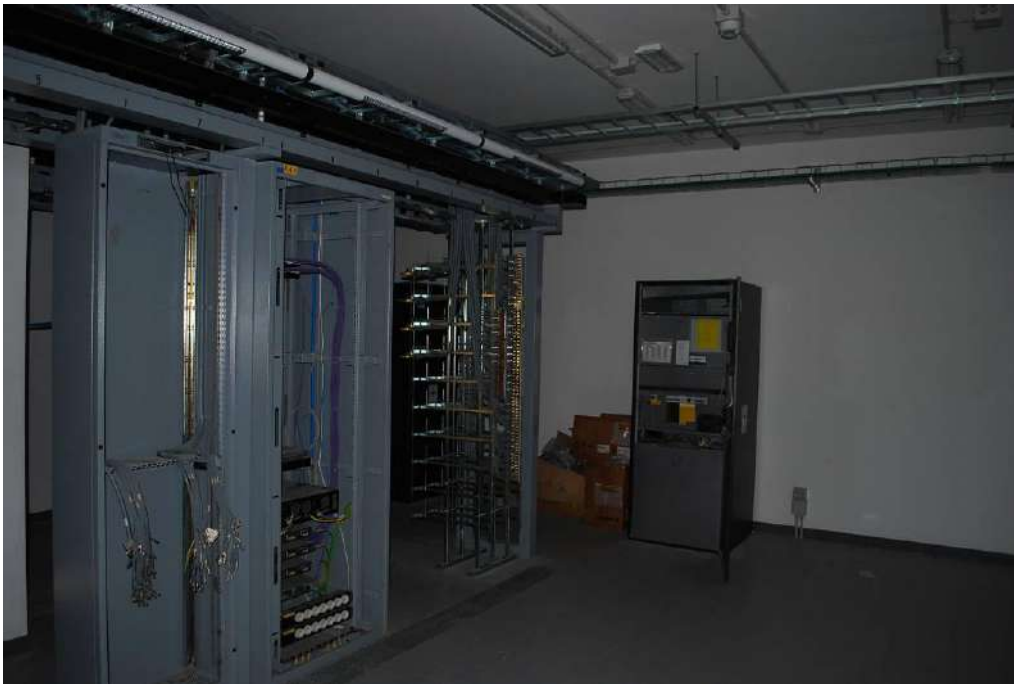
24. Interni piano terra (ex FASTWEB)
