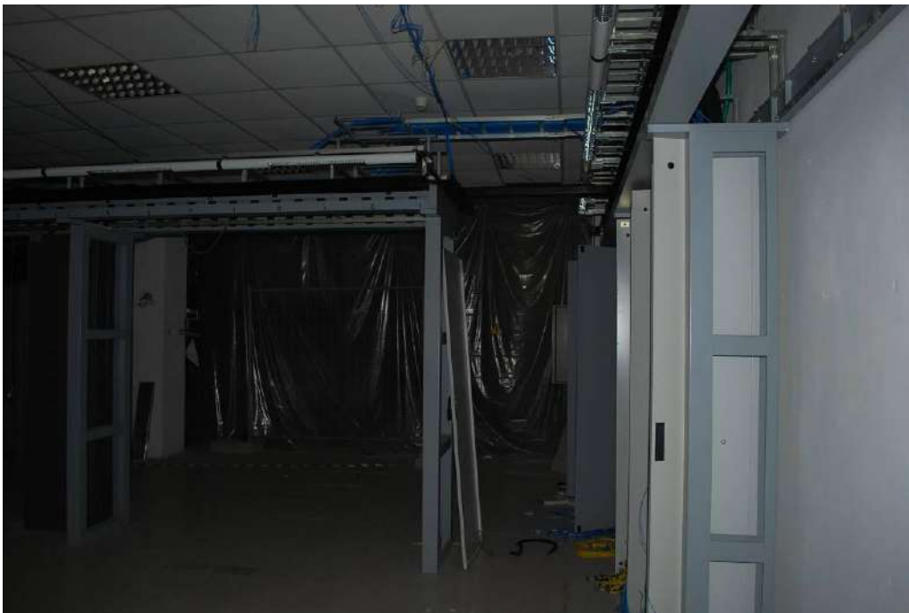
18. Interni piano terra (ex FASTWEB)
