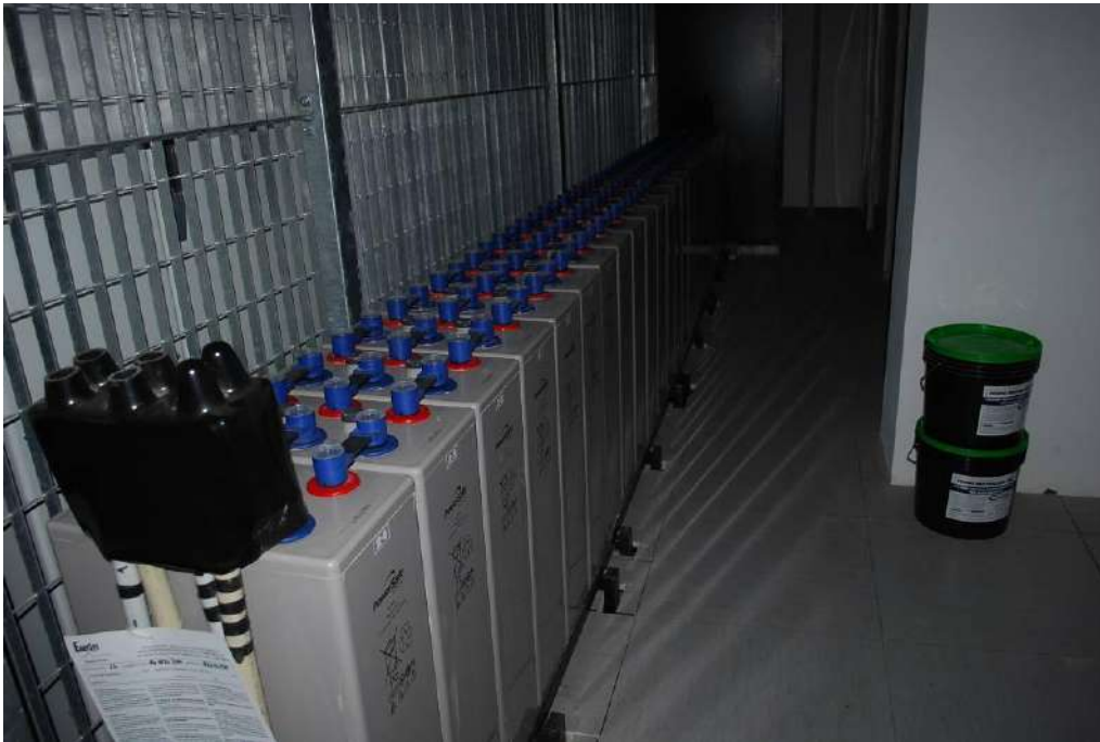
25. Interni piano terra (ex FASTWEB)
