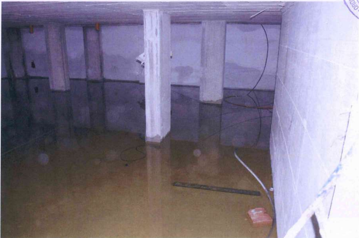
10. Veduta del piano interrato.
