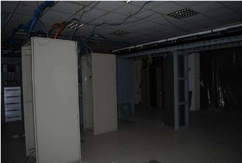
19. Interni piano terra (ex FASTWEB)
