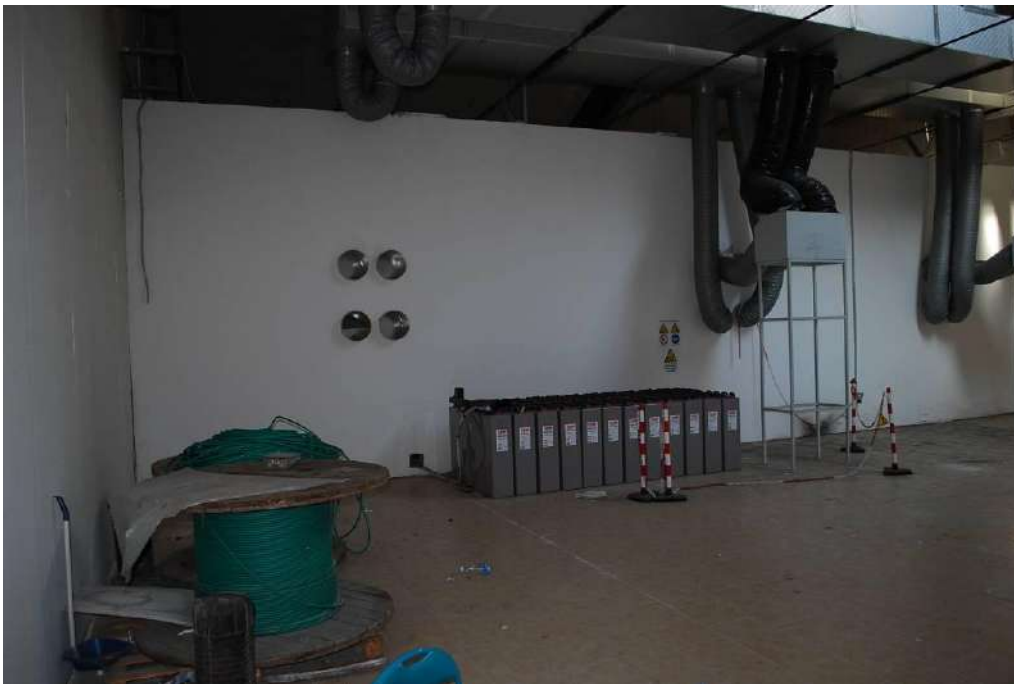
16. Interni piano terra (ex FASTWEB)
