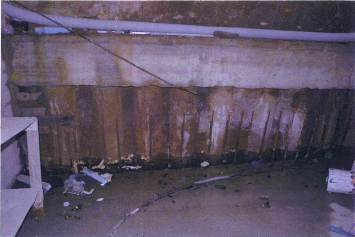
11. Veduta dei pali di sottofondazione.
