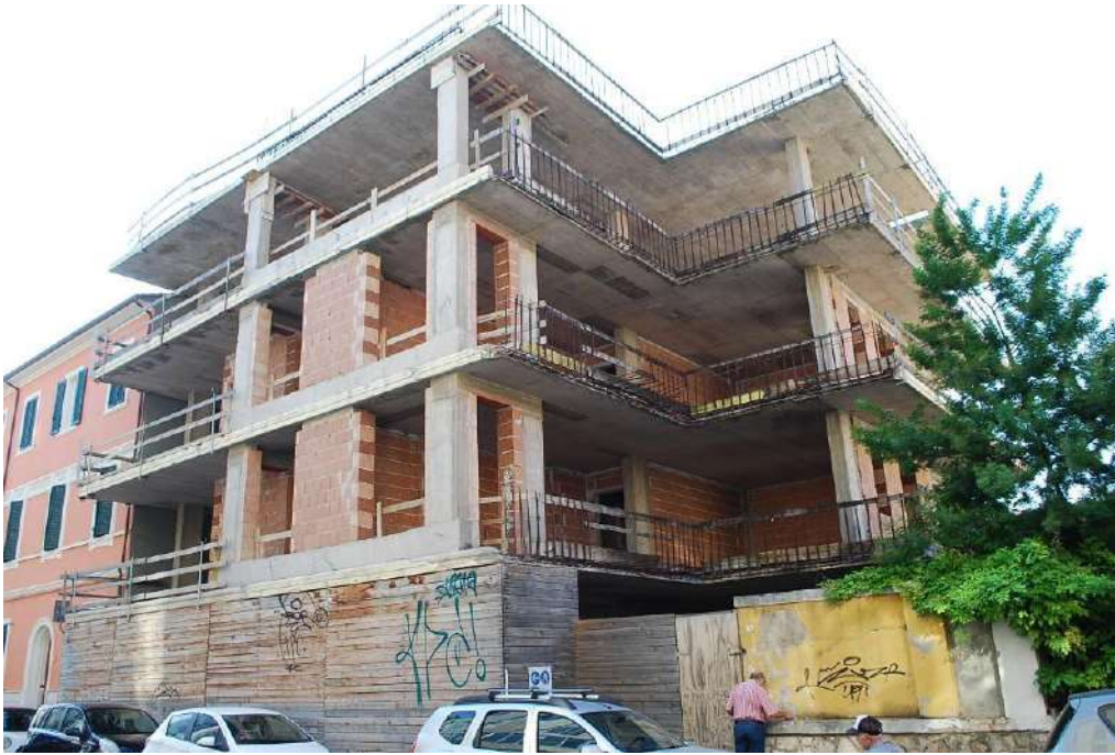
13. Veduta accesso di Via Bonghi
