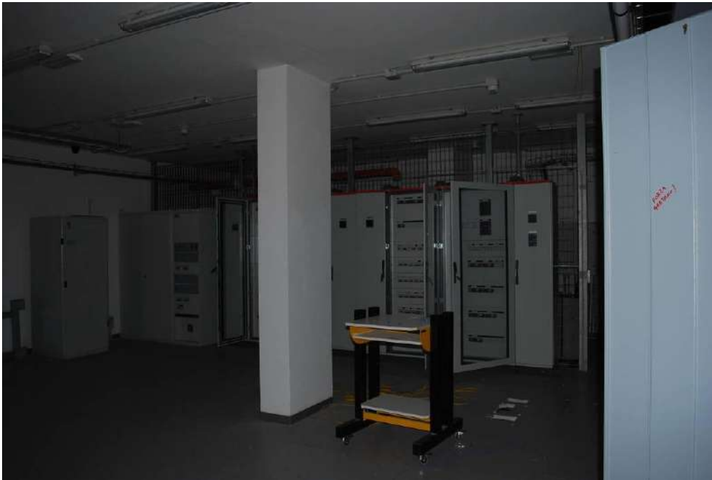
23. Interni piano terra (ex FASTWEB)
