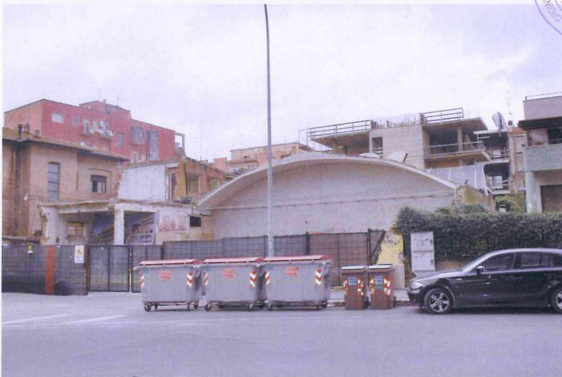
4. Area edificabile. Veduta del capannone parzialmente demolito da Via Manetti.
