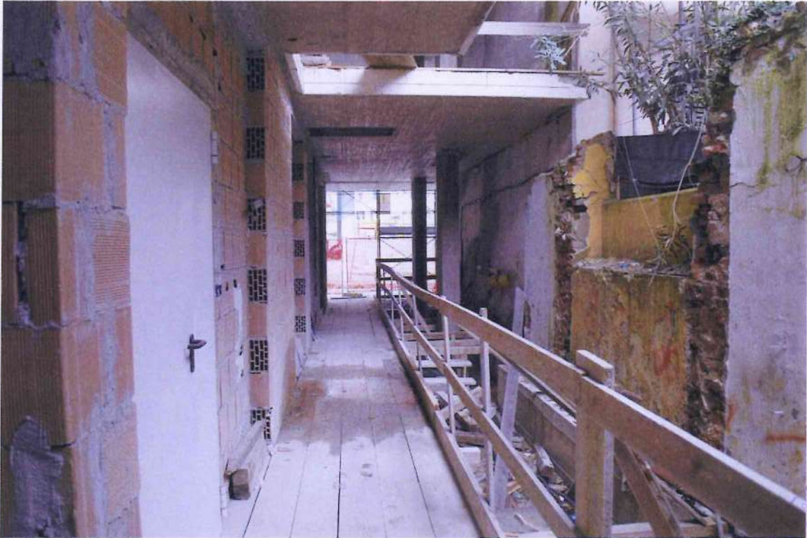
15. Altra veduta del cantiere.
