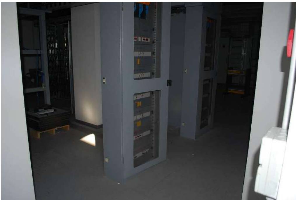
22. Interni piano terra (ex FASTWEB)
