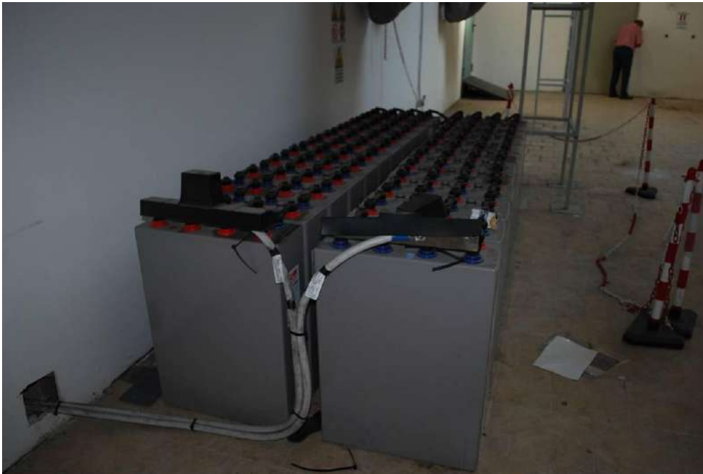
17. Interni piano terra (ex FASTWEB)
