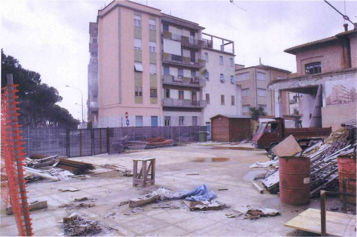
5. Area edificabile. Veduta dell'area approntata a cantiere.
