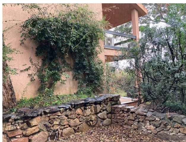
Foto 13. Esterno: il fianco nord del fabbricato.
