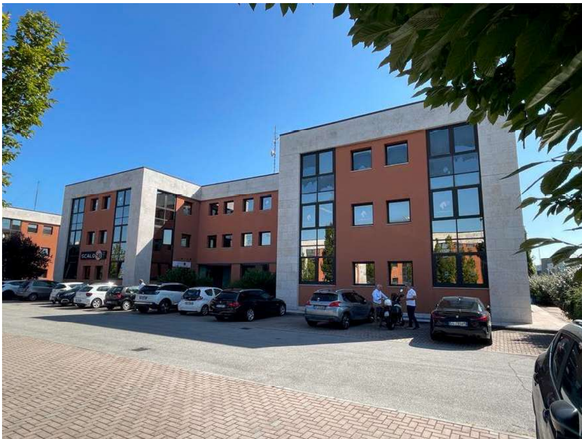
4 - Vista dell'edificio lato ovest
