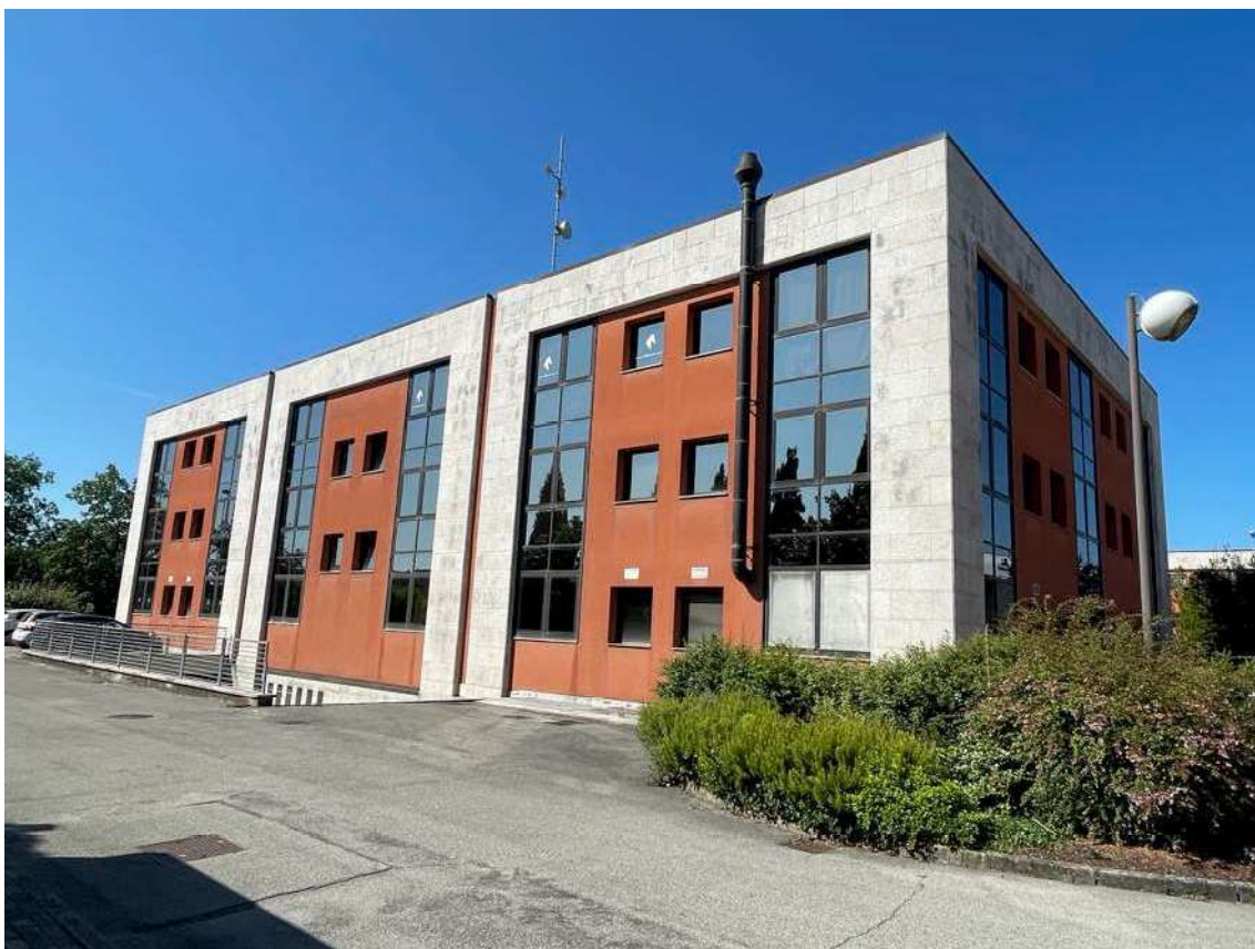
5 - Vista dell'edificio lato est
