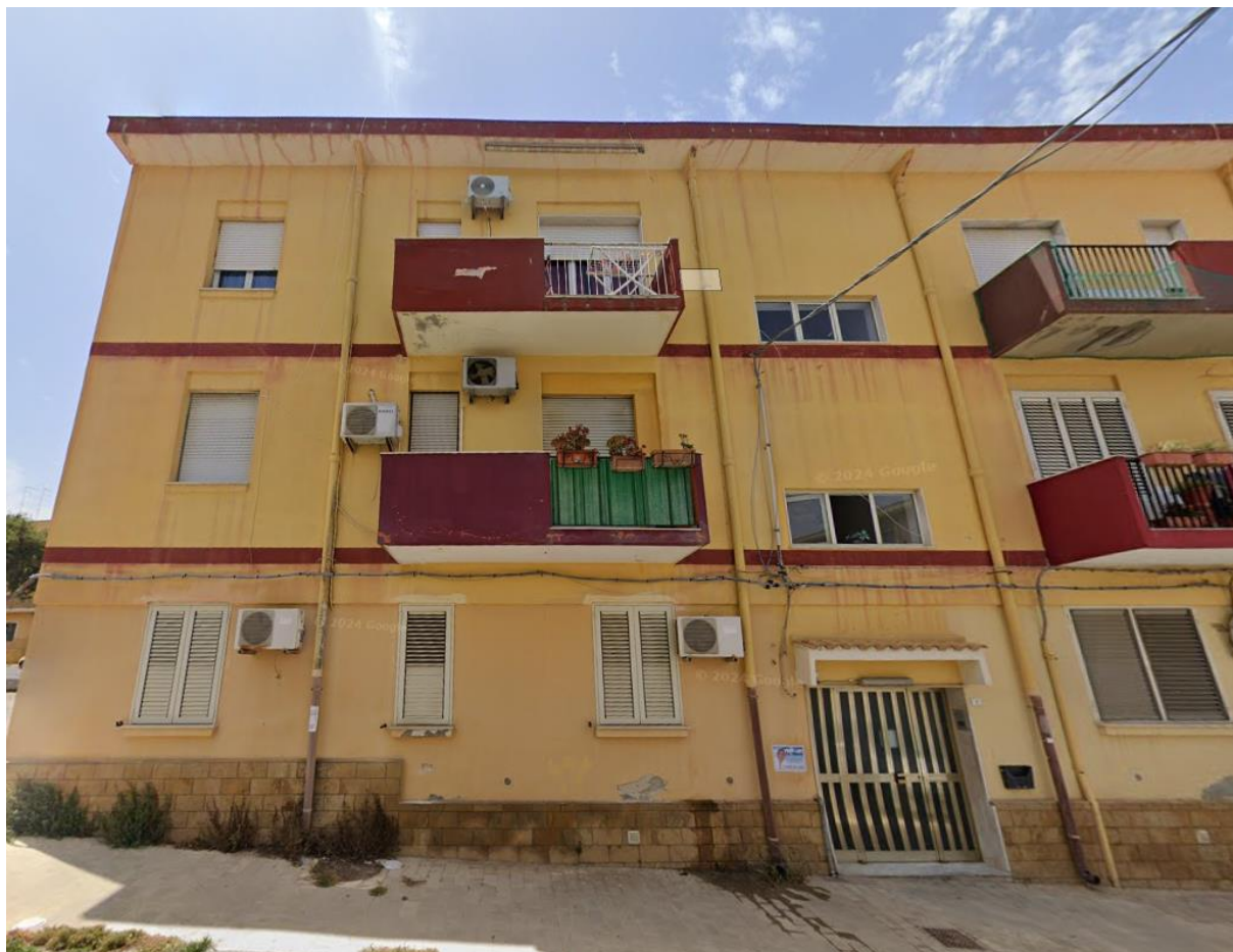
Vista ingresso lato est
