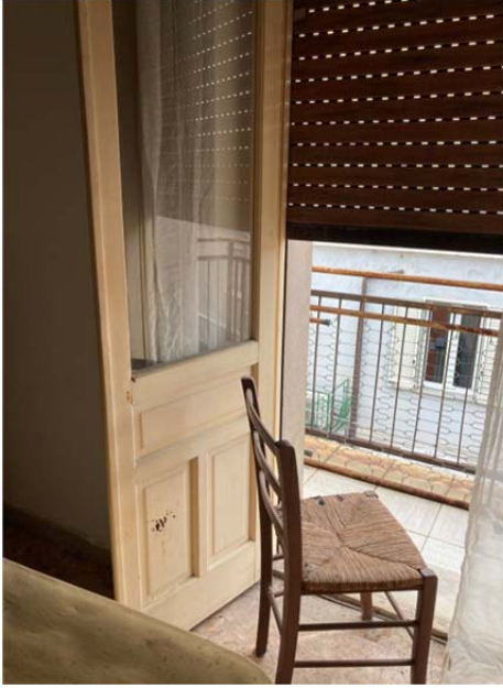
Foto 26. Interno: il balcone dell'ala a ovest.
