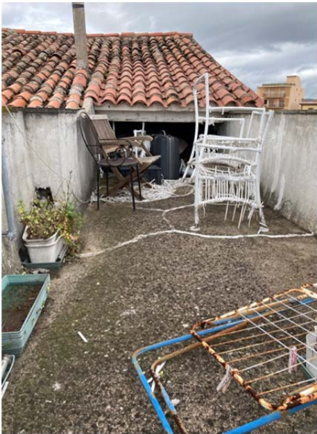
Foto 28. Esterno: il terrazzo sui tetti.
