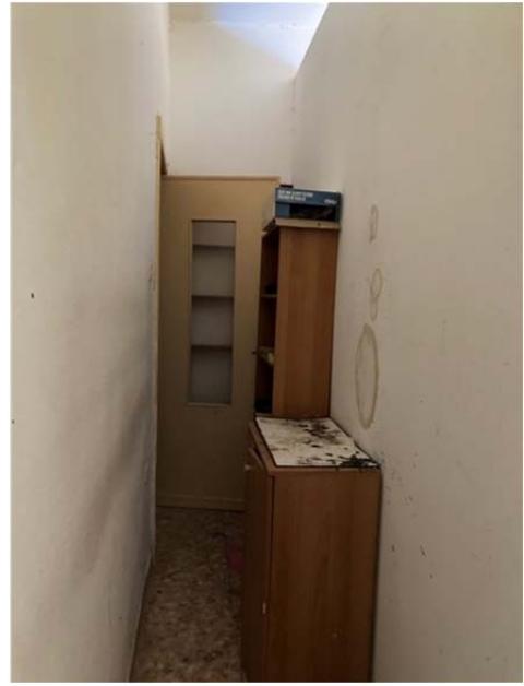
Foto 21. Interno: il disimpegno ala a ovest.
