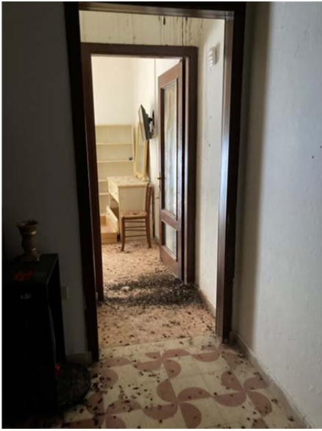
Foto 20. Interno: il disimpegno ala a ovest.
