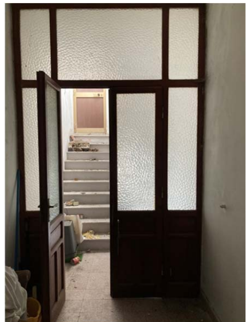
Foto 7. Interno: la porta a vetri lato interno.
