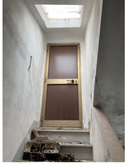
Foto 27. Interno: la porta per il terrazzo.
