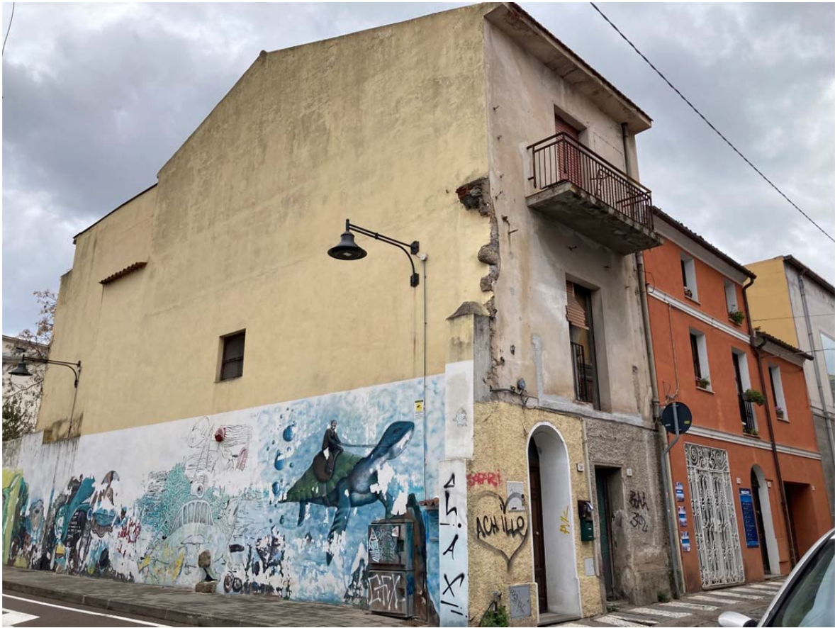
Foto 1. Esterno: il fabbricato. L'appartamento si trova al secondo piano.
