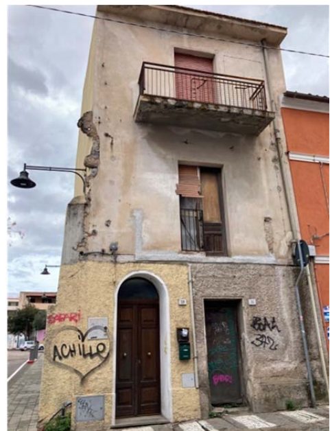
Foto 3. Esterno: il fronte su via Porto Romano.
