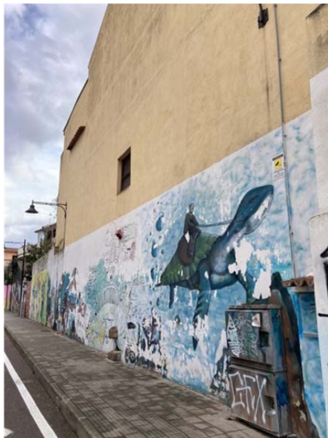
Foto 2. Esterno: il lato nord del fabbricato.
