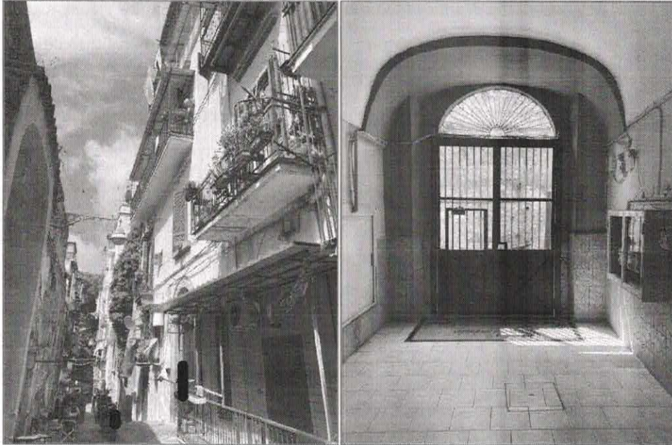
Figura 2. Prospetto del fabbricato da Vico Tessitori ai Miracoli (sinistra) e androne/cortile interno (destra).
