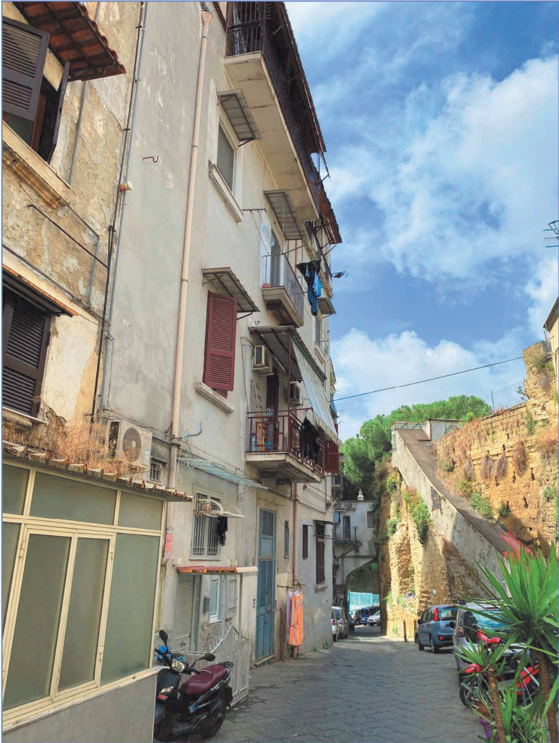
FOTO 2. PROSPETTO FABBRICATO SU VICO TAVERNOLA.
