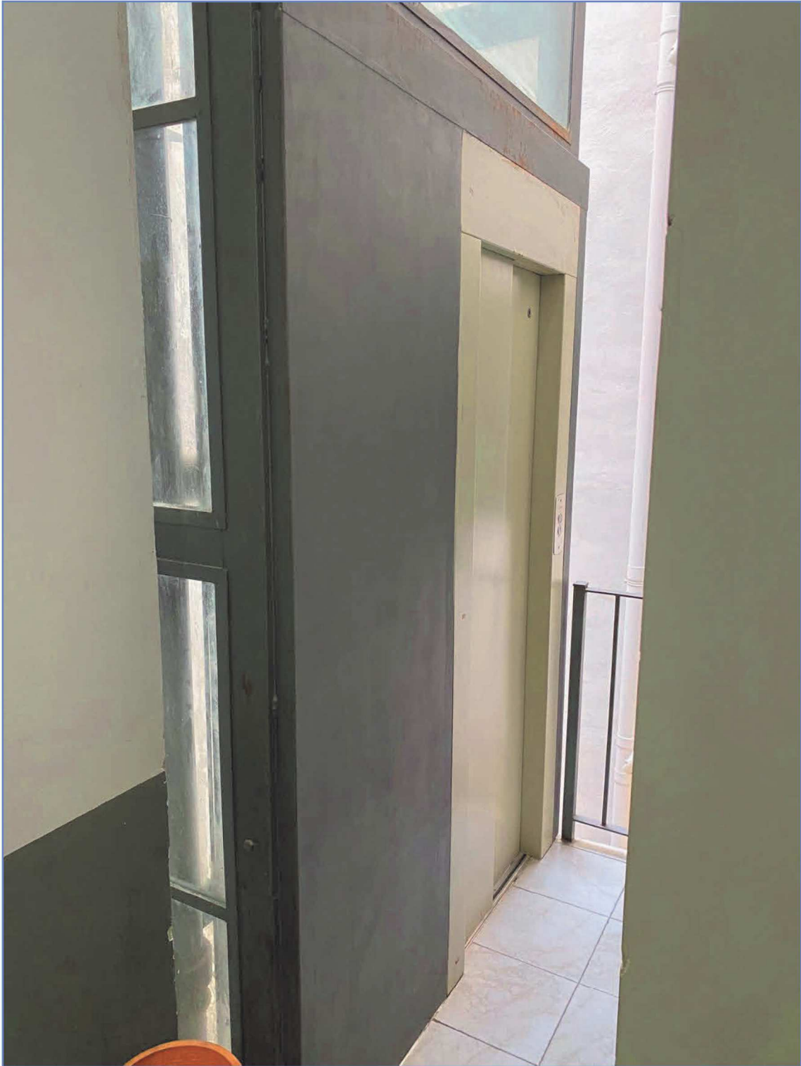
FOTO 7. VANO ASCENSORE FABBRICATO.
