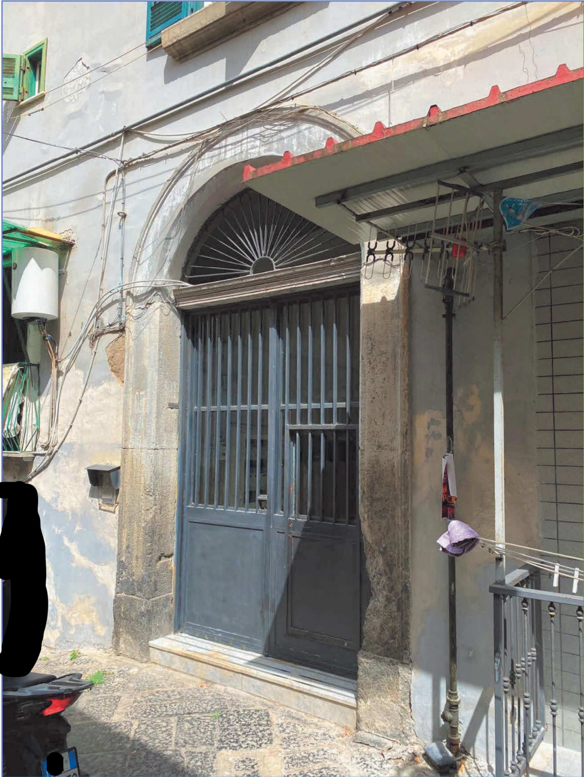
FOTO 3. INGRESSO FABBRICATO DA VICO TESSITORI AI MIRACOLI N. 26.
