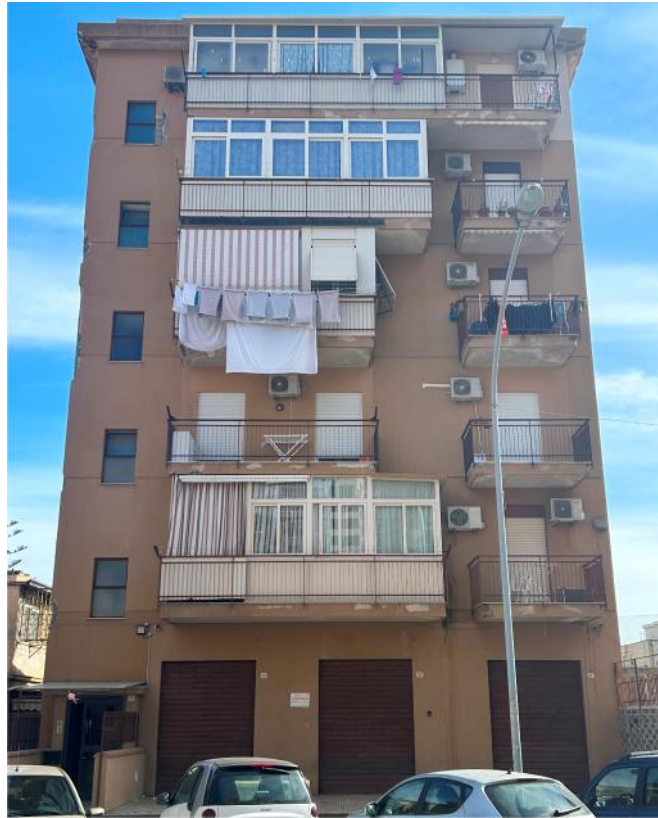
Foto n. 1 - L'edificio frontalmente (l'appartamento è al primo piano)
