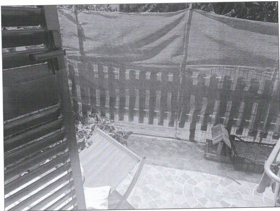
Fotografia 16: Lastrico solare al piano primo
