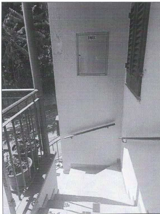
Fotografia 7: Ingresso principale dell'unità di civile abitazione
