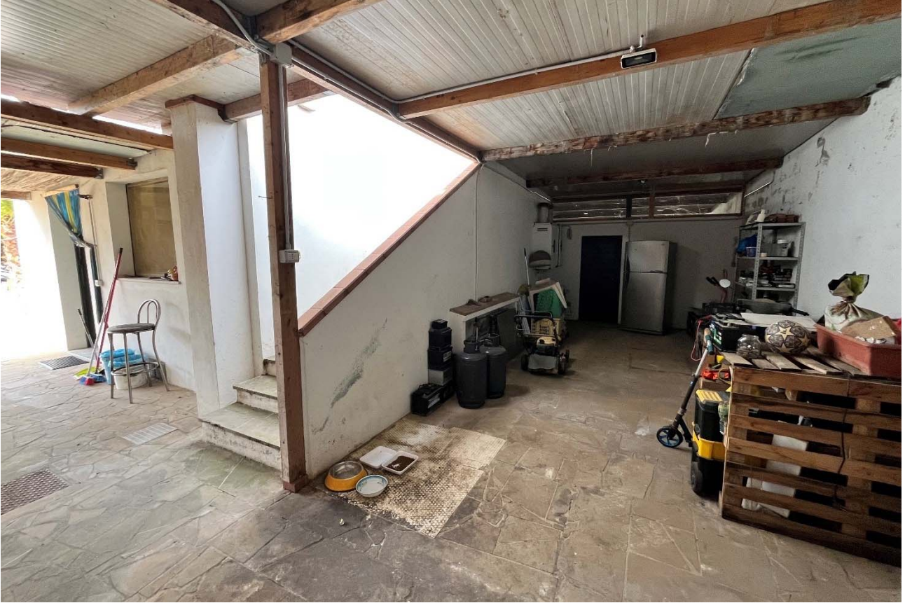
Vuoto tecnico e scala di accesso al piano primo
