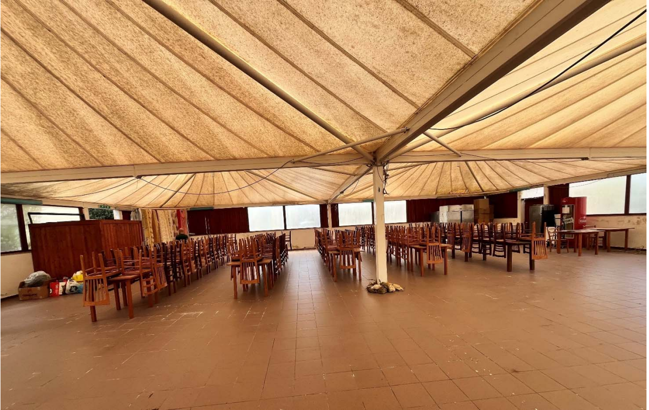
Vista interna tensostruttura
