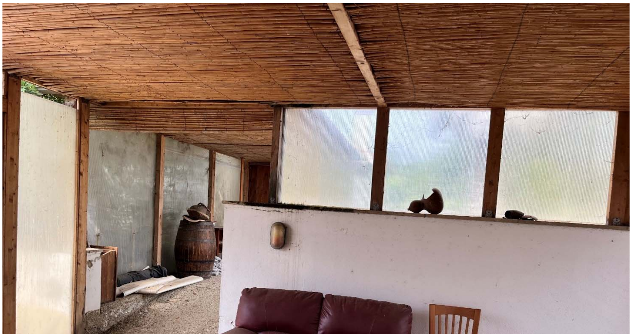
Copertura con cannicciato dalla veranda al barbecue
