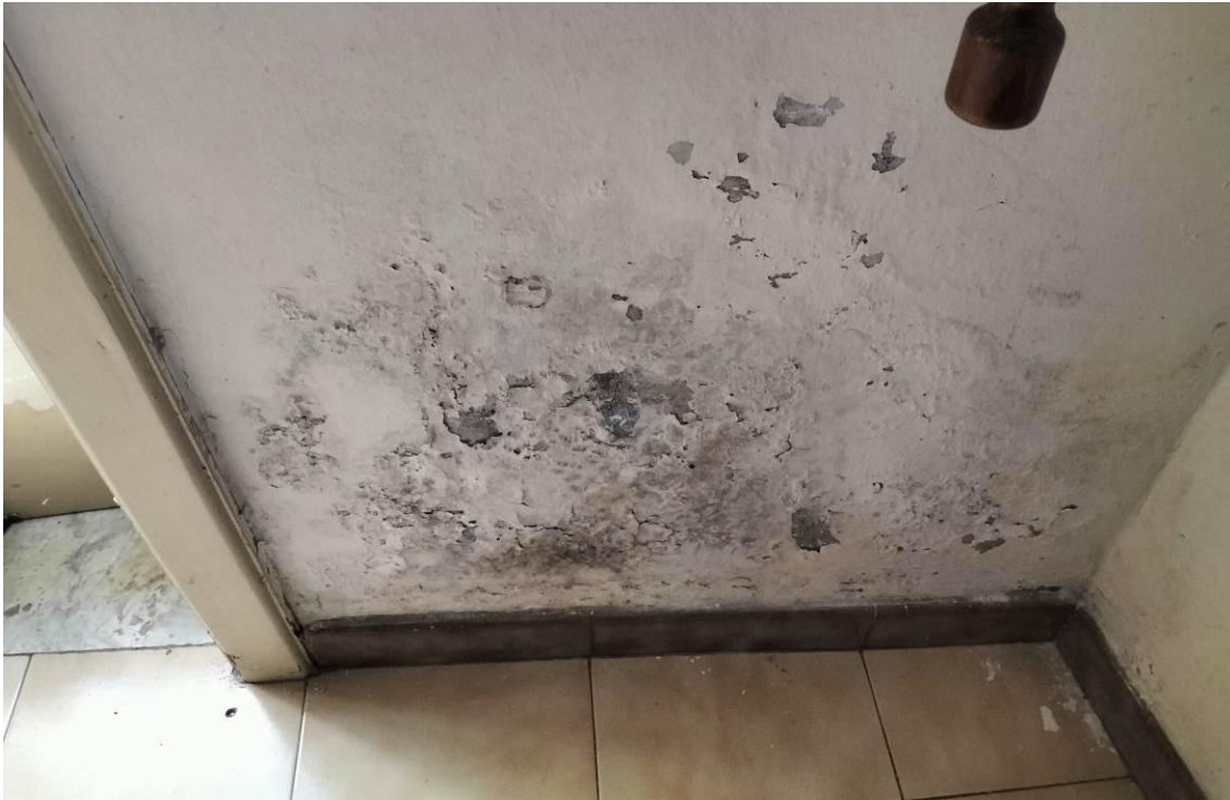
Particolare muratura – camera 1
