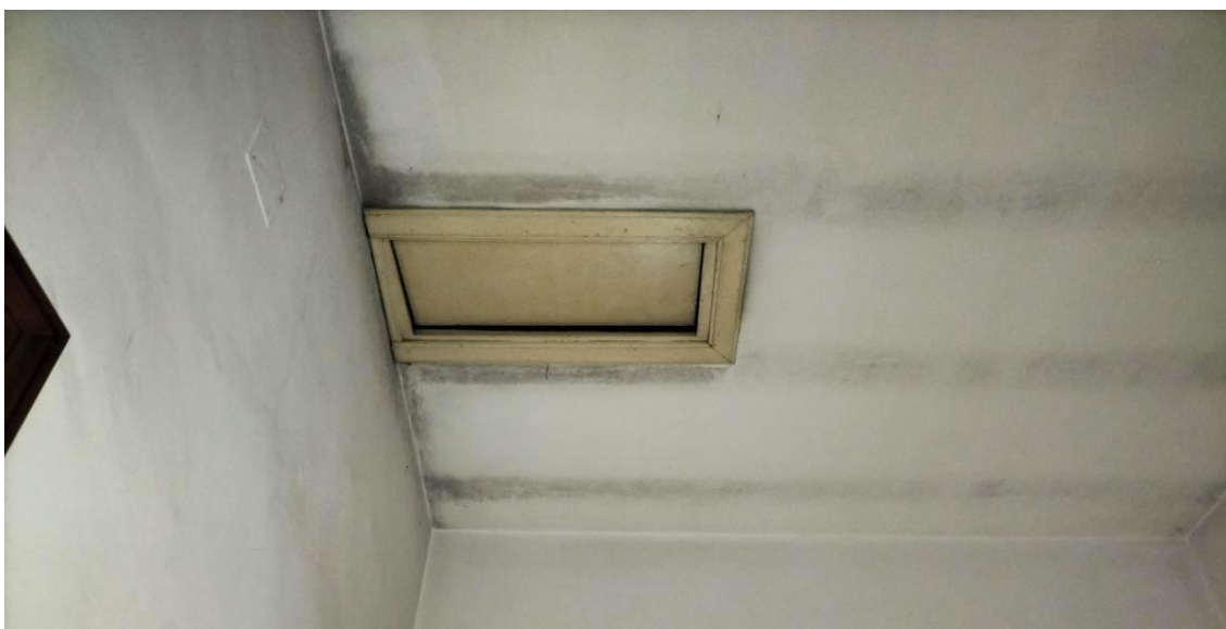
Botola d'accesso al soffitto
