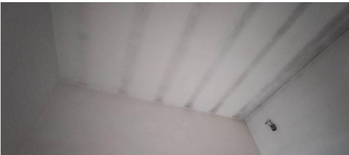
Particolare intradosso solaio
